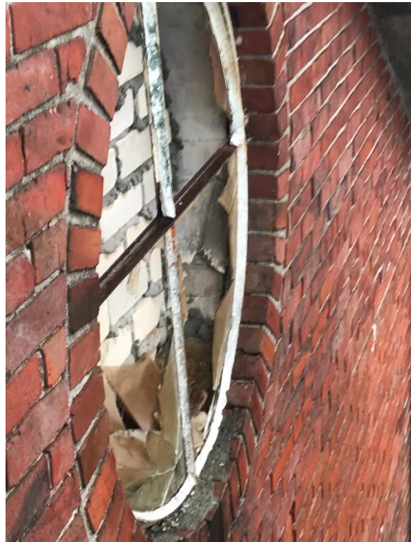
Afb. 10 Zicht op de linker zijgevel, met ook hier redelijk metselwerk, maar tevens kapotte vensters en afdekkingen
