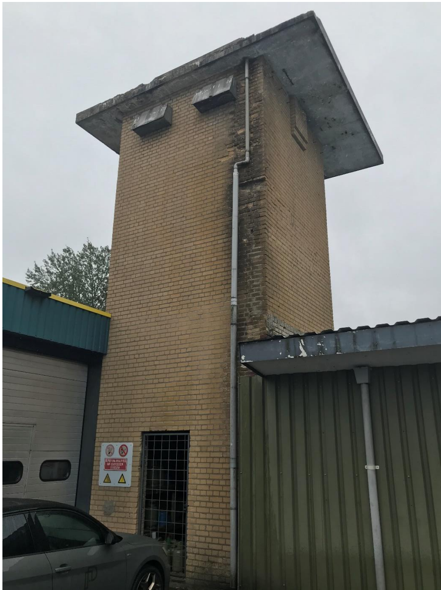
Afb. 11 De zogenaamde plofbunker, redelijk metselwerk, maar de afdekking in een slechte staat. Langdurige lekkage langs de hemelwaterafvoer, waardoor het voegwerk is uitgespoeld en het metselwerk is vervuild en verzadigd
