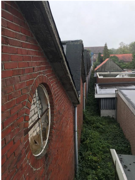
Afb. 10 Zicht op de linker zijgevel, met ook hier redelijk metselwerk, maar tevens kapotte vensters en afdekkingen
