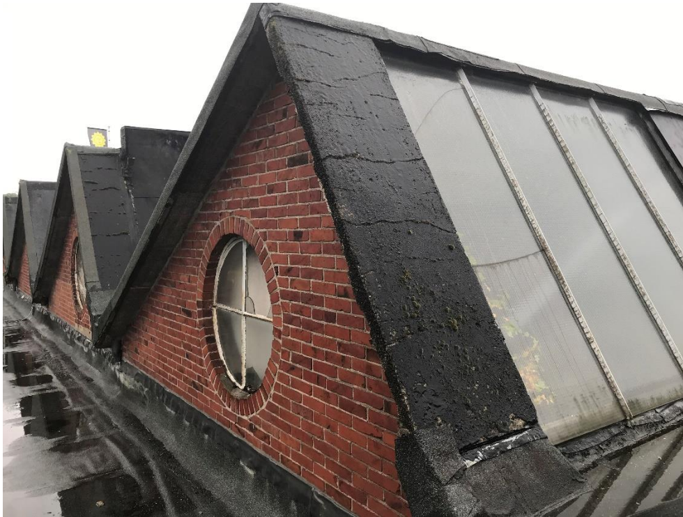
afb. 5 Redelijk metselwerk van de topgevels, afdekkingen zwaar aangetast
