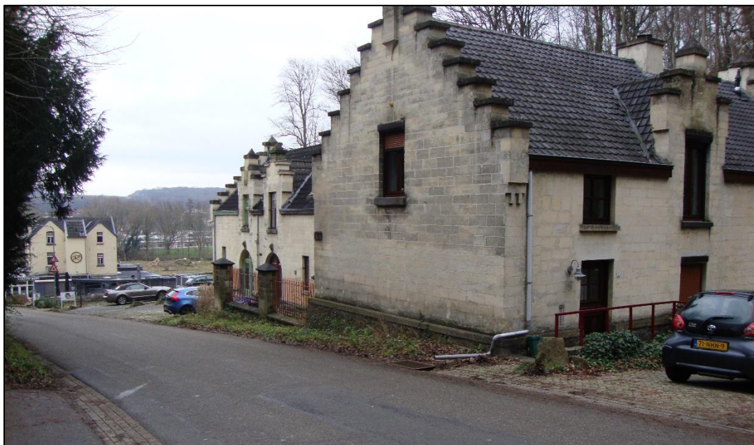
De woningen Vogelzangweg 1 t/m7 in de voormalige koetshuizen
