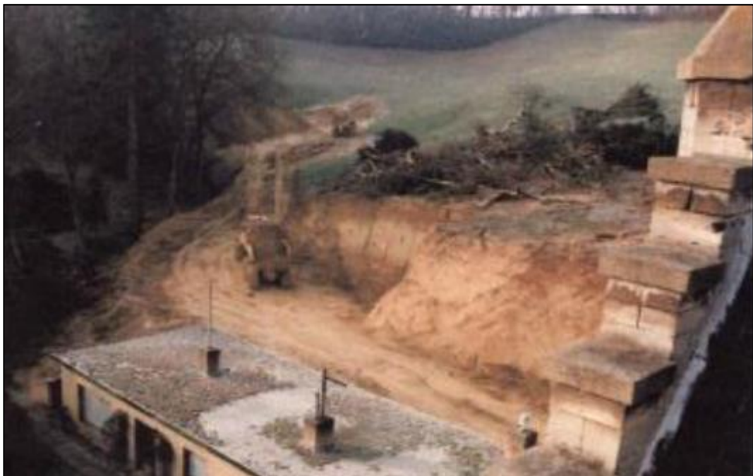
Grondwerkzaamheden n.a.v. bouwvergunning 1992 (2)
