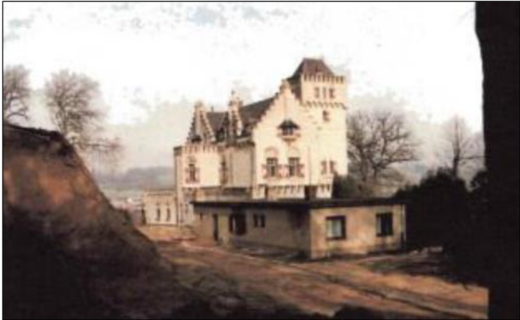
Grondwerkzaamheden n.a.v. bouwvergunning uit 1992 (1)
