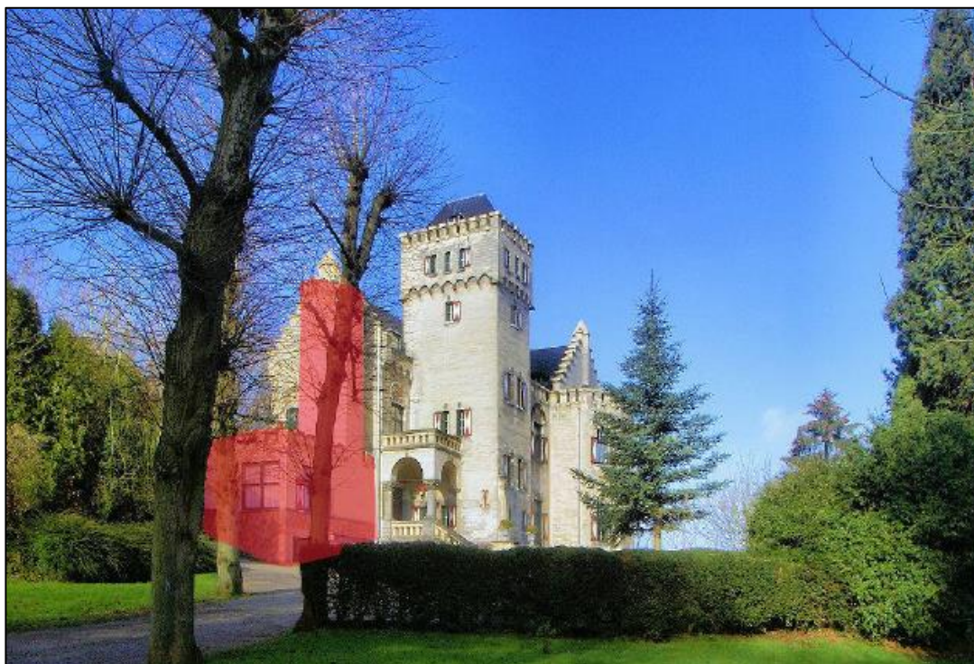
Te slopen gedeelte van het gebouw
