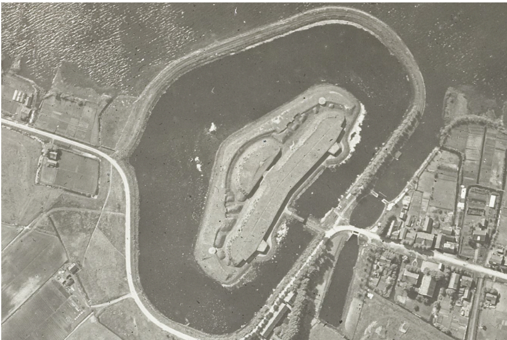
LUCHTFOTO UIT 1906 TEN TIJDE VAN DE AANLEG VAN HET FORT MET ZICHT OP HET ZANDLICHAAAM. DE TWEE GESCHUTSPLAATSEN BIJ DE HEFKOEPELS LIJKEN AL TE ZIJN AANGELEGD. (NEDERLANDS INSTITUUT VOOR MILITAIRE HISTORIE)
