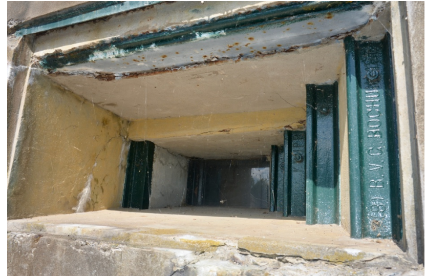
DETAIL VAN DE SCHIETOPENING IN DE WESTELIJKE KEELKAZEMAT MET ZICHT OP GROEN GESCHILDERDE SPOORSTAVEN WAAROP DE NAAM VAN DE PRODUCENT STAAT: B.V.G. BOCHUM. DE BOCHUMER VEREIN WAS EEN DUITSE MIJNBOWGROEP WAARTOE OOK STAAL-PRODUCENTEN BEHOORDEN.
