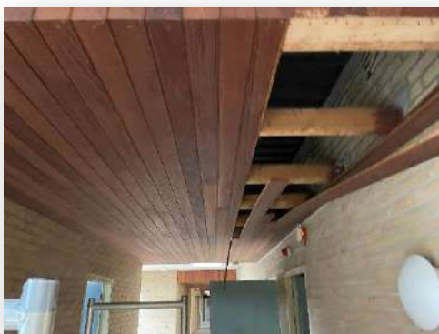
Overzicht destructief onderzoek
