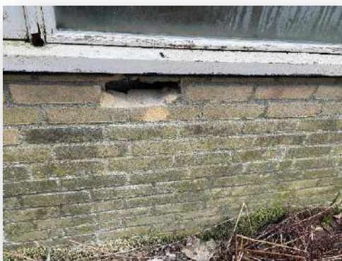
Overzicht destructief onderzoek
