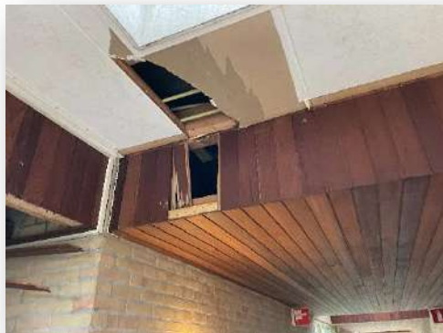
Overzicht destructief onderzoek
