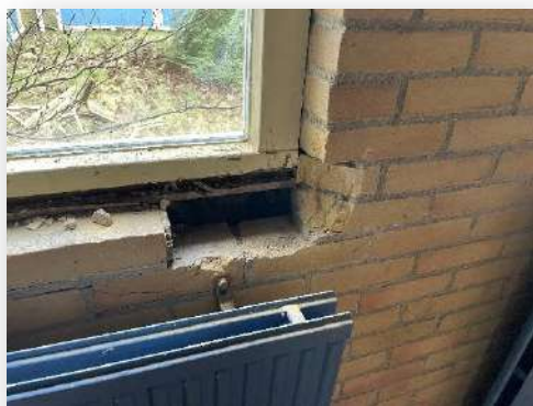
Overzicht destructief onderzoek
