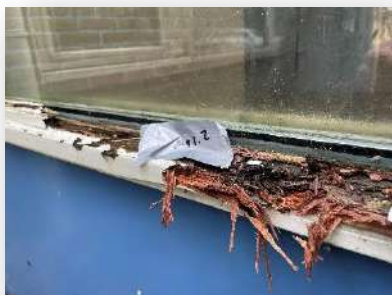
Bron M1.1 en M1.2 Asbestvrij Kit (rond raamwerk en borstweringen) Totaal n.v.t.
