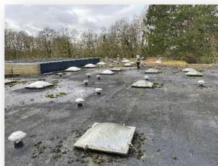
Bron M6 en M6.1 Asbestvrij Bitumen dak Totaal n.v.t.
