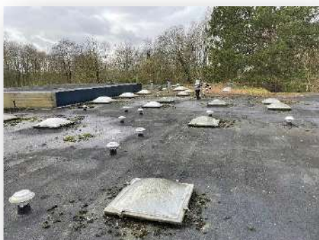
Overzicht asbestvrij dak
