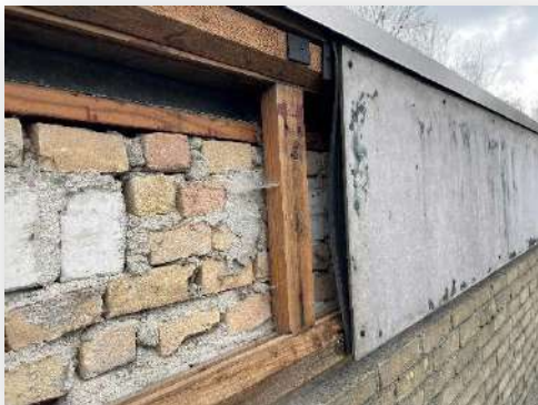
Destructief onderzoek dakopbouw
