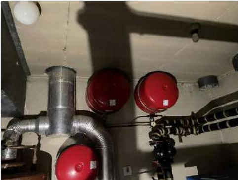
Overzicht plafond cv ruimte
