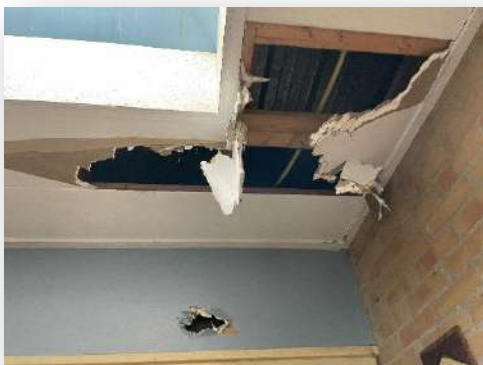
Overzicht destructief onderzoek
