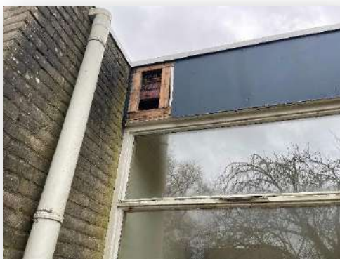
Overzicht destructief onderzoek
