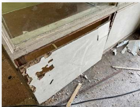
Overzicht destructief onderzoek
