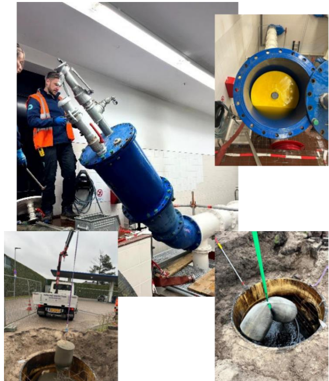
Figuur 3: inbrengen en uithalen schuimpluggen
