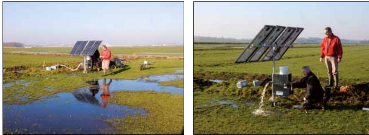
Figuur 13 Pompen installeren (foto's: Bas Blok)
