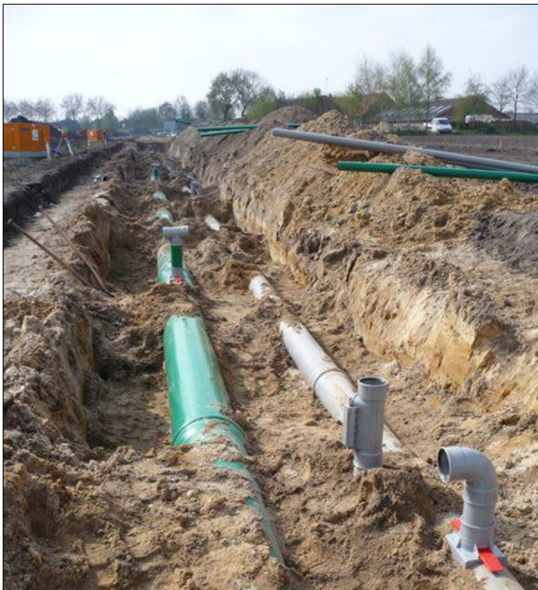
Afbeelding 15: Aanleg gescheiden riool De Donk
