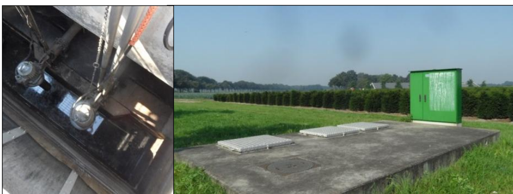
Afbeelding 14: Bergbezinkvoorziening gemengd rioelstelsel
