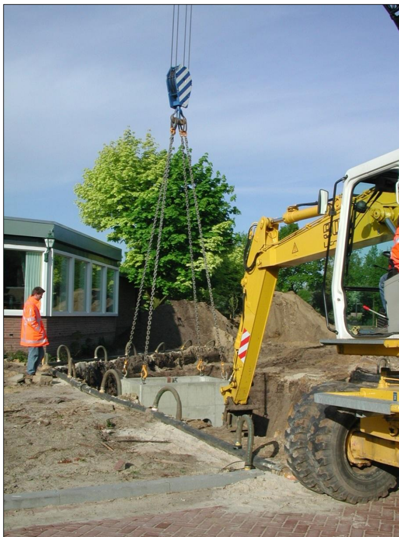
Afbeelding 4: Plaatsen regenwaterafvoer gemaal centrum Boekel
