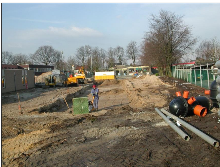
Afbeelding 13: Aanleg infiltratievoorziening Parkweg (afkoppelen)
