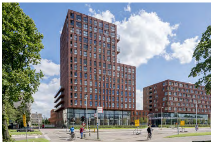
Woontoren De Verkenner, Utrecht
