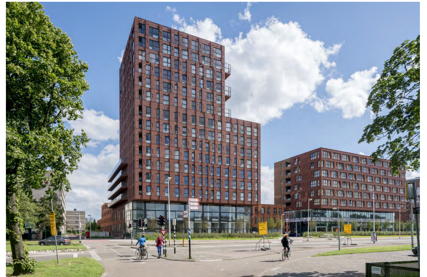
Poortwachter voor Kanaleneiland, aan het 5 mei plein (Churchillaan)
