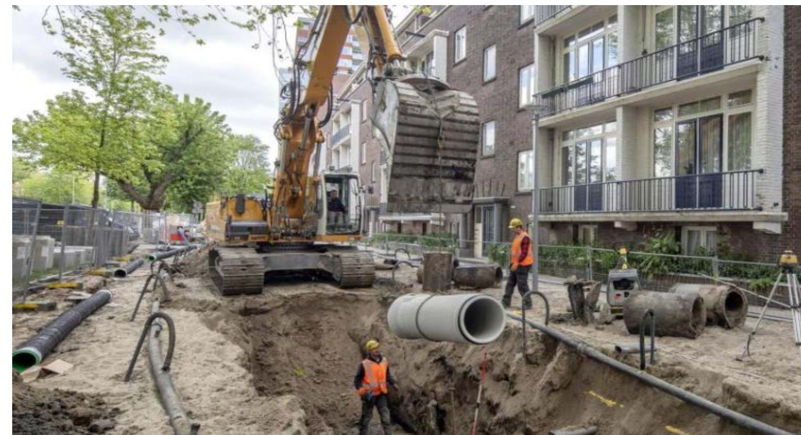
Aanleg gescheiden rioolstelsel
