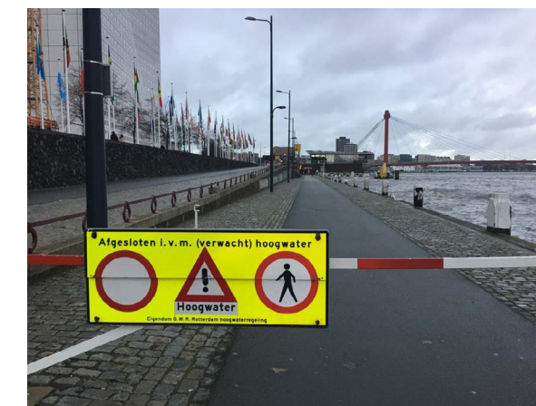
Bolwerk, laagste kade; circa 40x afgesloten in stormseizoen '23-'24
