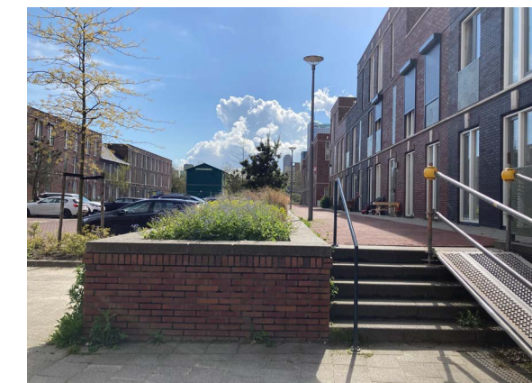
Verhoogd trottoir en woningen Bottelaarstraat
