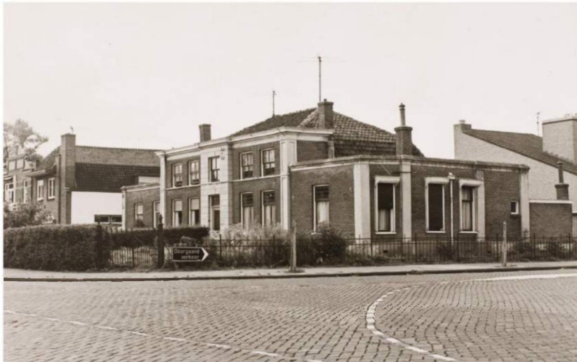
Foto 1972; vlak voor de sloop van deze twee huizen op de hoek van de Grote Woerdlaan
