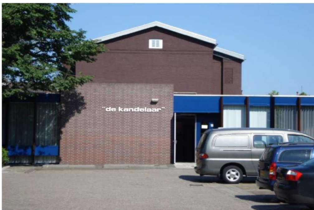
Foto 2008; Dijkweg 19. Het vroegere Evangelisatiegebouw werd in 1977, 1978 en 1979 vernieuwd en uitgebreid. Het kreeg de naam "de kandelaar". Tot 2013 werden hier kerkdiensten gehouden, toen verhuisde de gemeente naar de Ontmoetingskerk in de Anjerlaan. Sinds 2016 is in het gebouw o.a. een huisartsenpraktijk en apotheek gevestigd.
