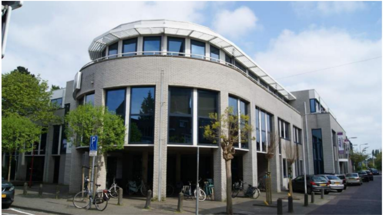
Foto 2017; een accountantsbureau op de plaats van de school
