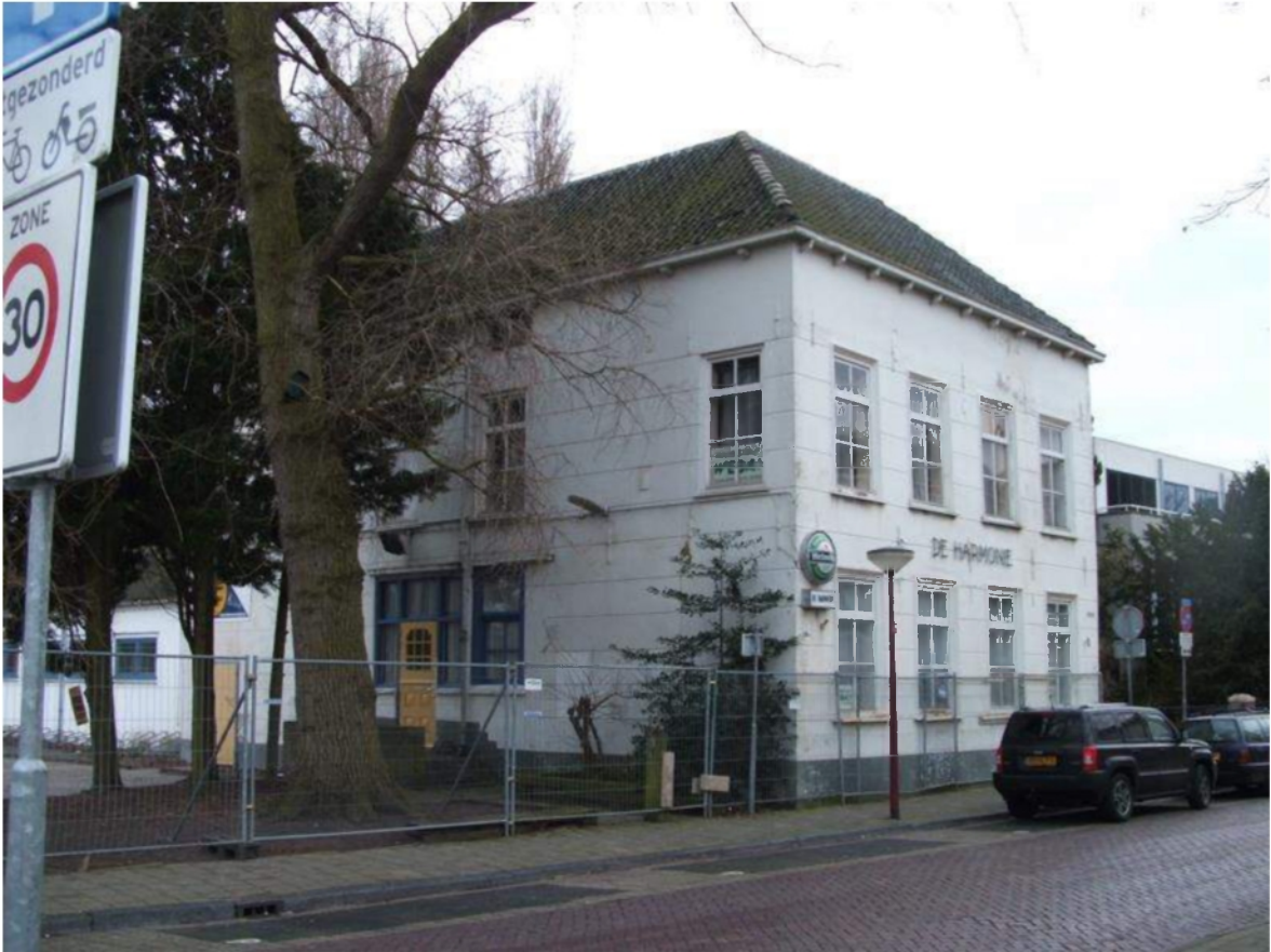
Afbeelding 11 De voormalige pastorie van de R.K.-kerk aan de Dijkweg, later De Harmonie, foto 2009. Bron: Historisch Archief Westland, 2017.
