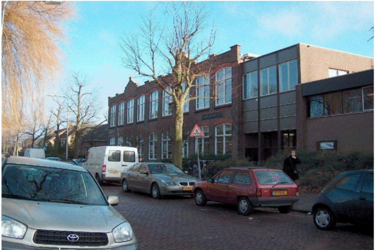
Foto 2006; Naast de school is een grote sportzaal gebouwd. In 2008 is een nieuwe Bernadetteschool gebouwd in het Woerdblok.
