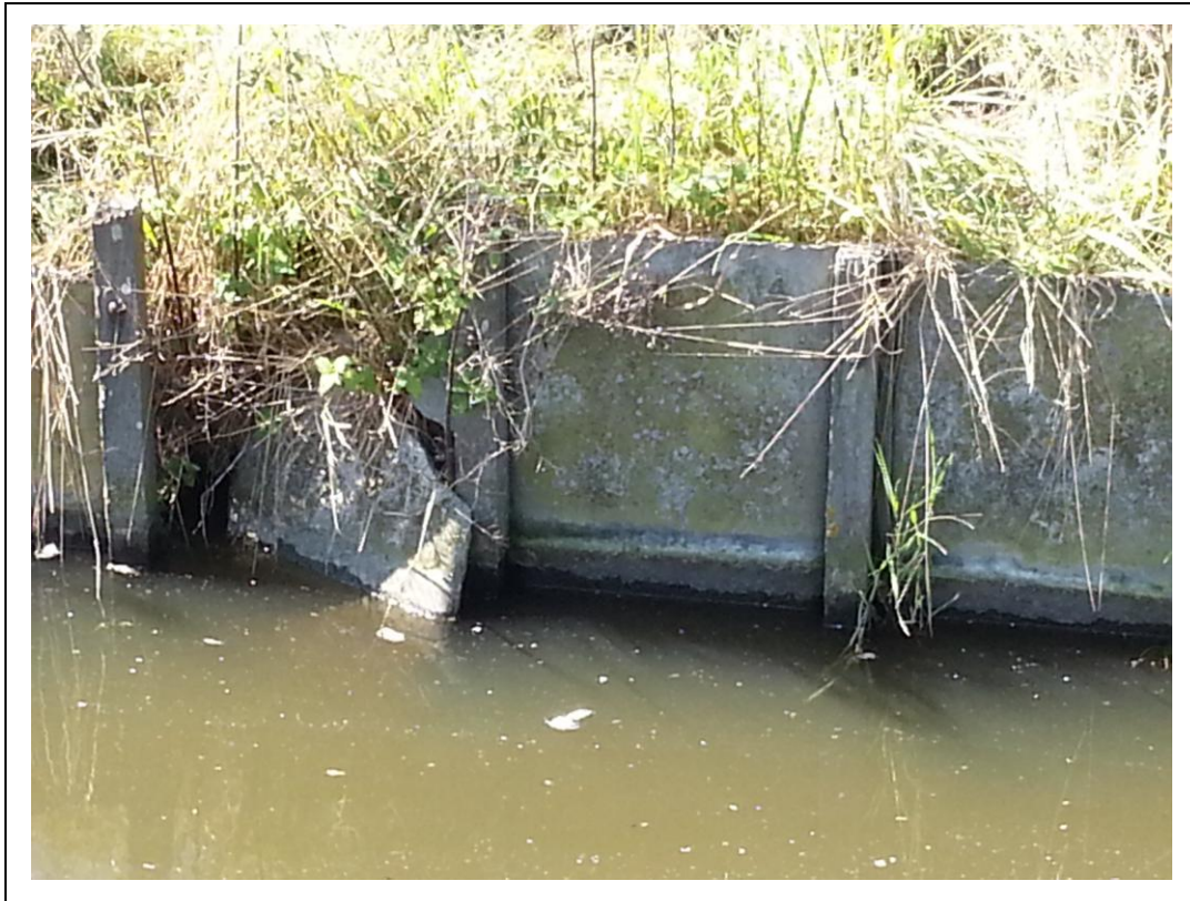
Foto 17. Betonnen oeverbescherming
