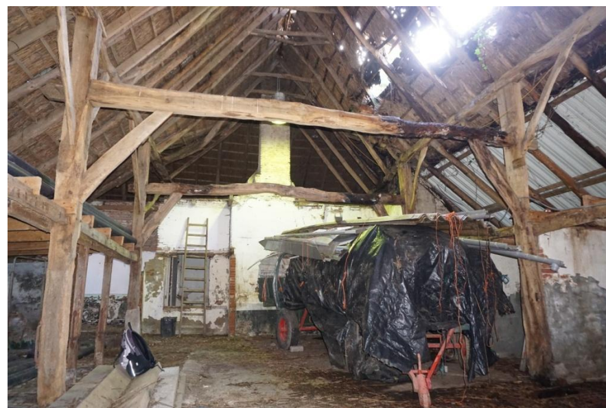
Overzicht van de gebintconstructie in 0.7
