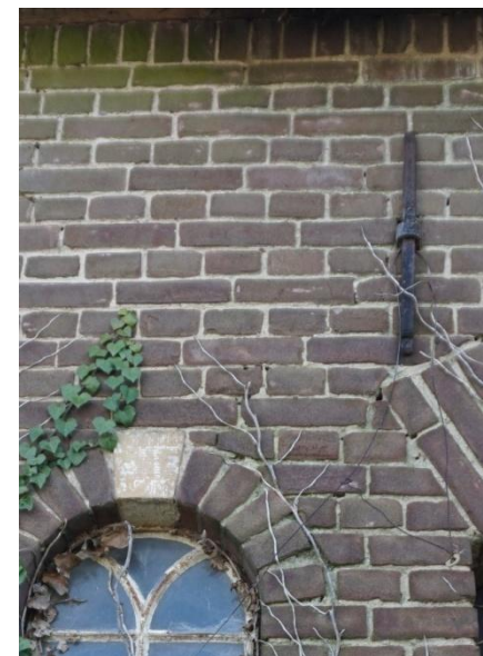
Metselwerk van de noordgevel uit 1911
