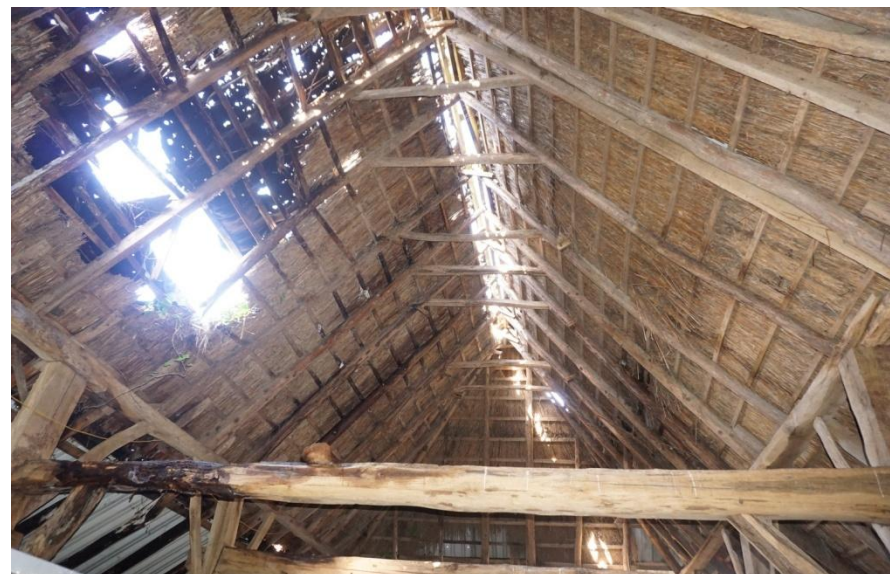
Sporenkap boven de deel 0.7
