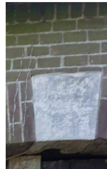
Sluitsteen uit 1834 in de noordgevel
