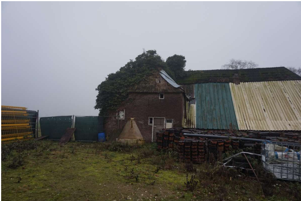
Figuur 2.4. Te slopen vervallen boerderij met aanbouw.
