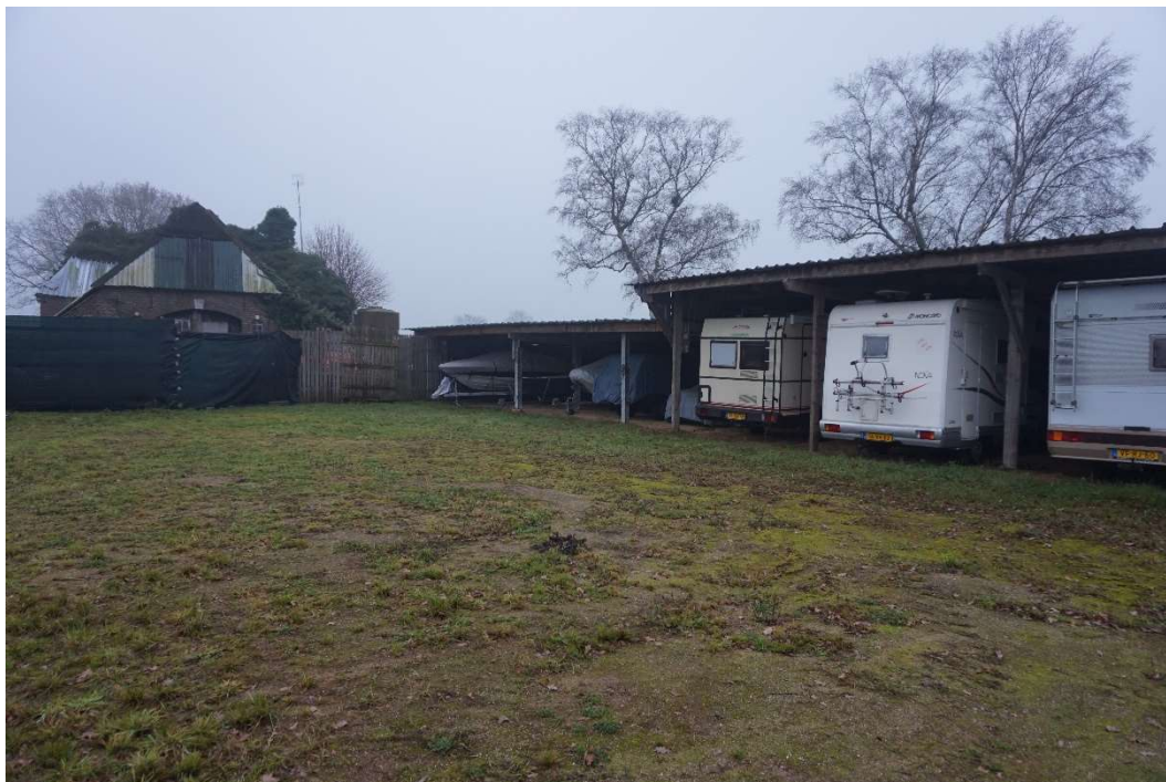
Figuur 2.2. Te slopen kapschuur ter plaatse van het plangebied.
