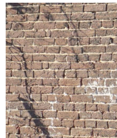
Metselwerk van de oostgevel uit 1886
