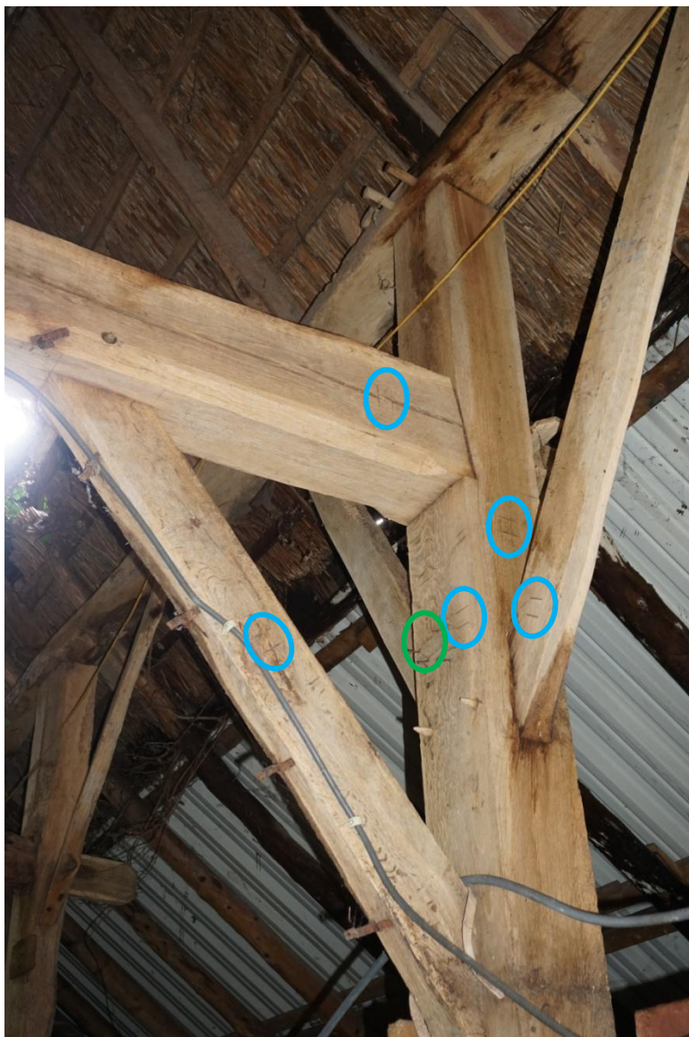
Telmerken op een ankerbalkgebint: I en II
