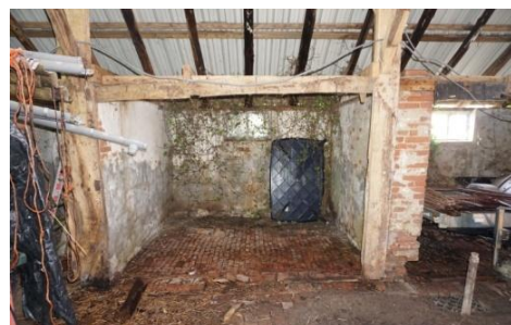
Ruimte aan de westzijde in deel 0.7
