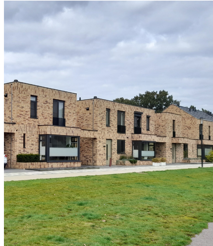
Gevels, balkons, plantenbakken en voorzones vormen één compositie
