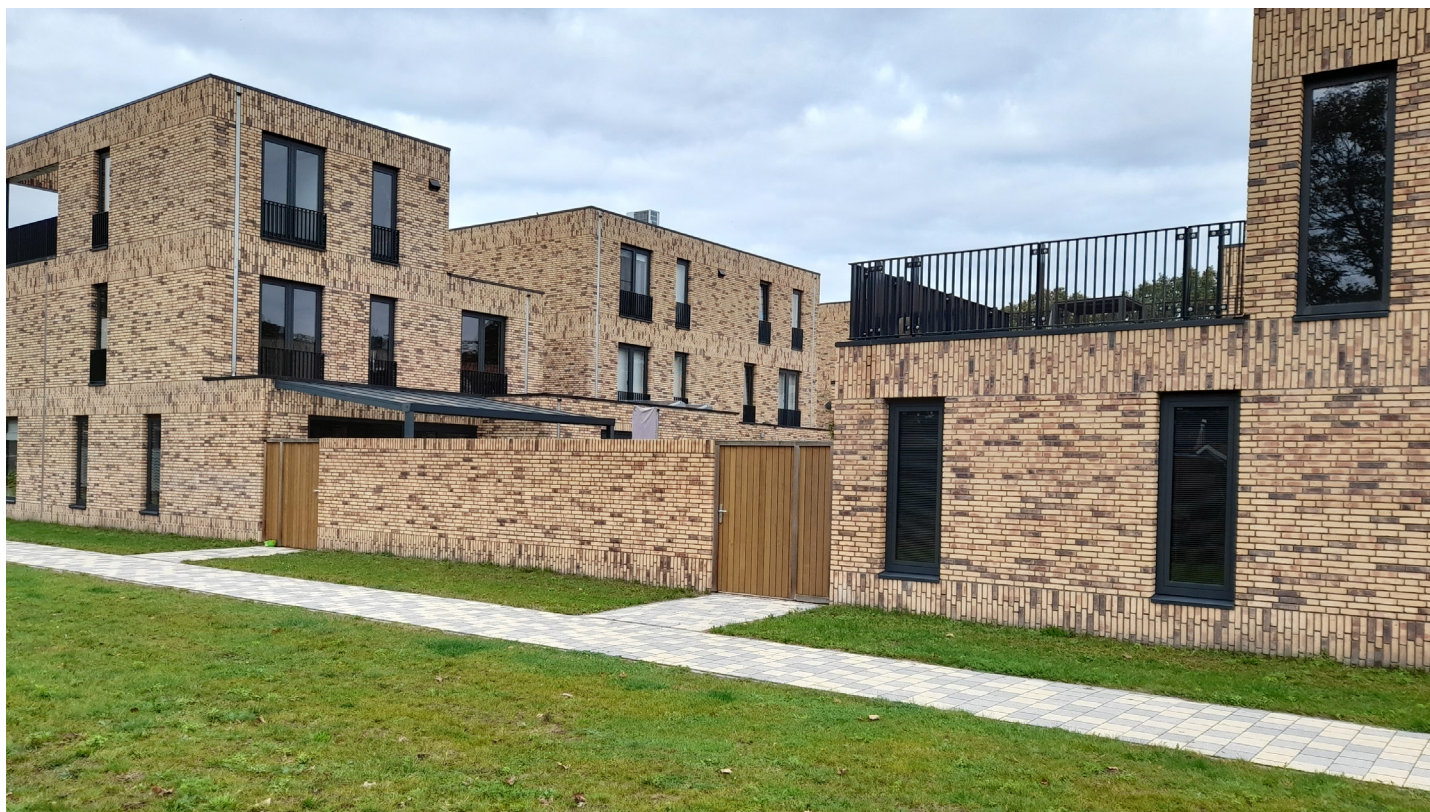
Vocabulair van meeontworpen tuinmuren en woningen (diverse patronen metselwerk). Gevels en muren direct aan het groen.
