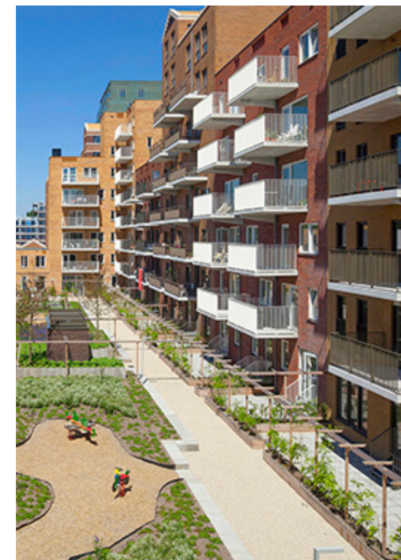
Appartementen aan een collectieve dektuin
