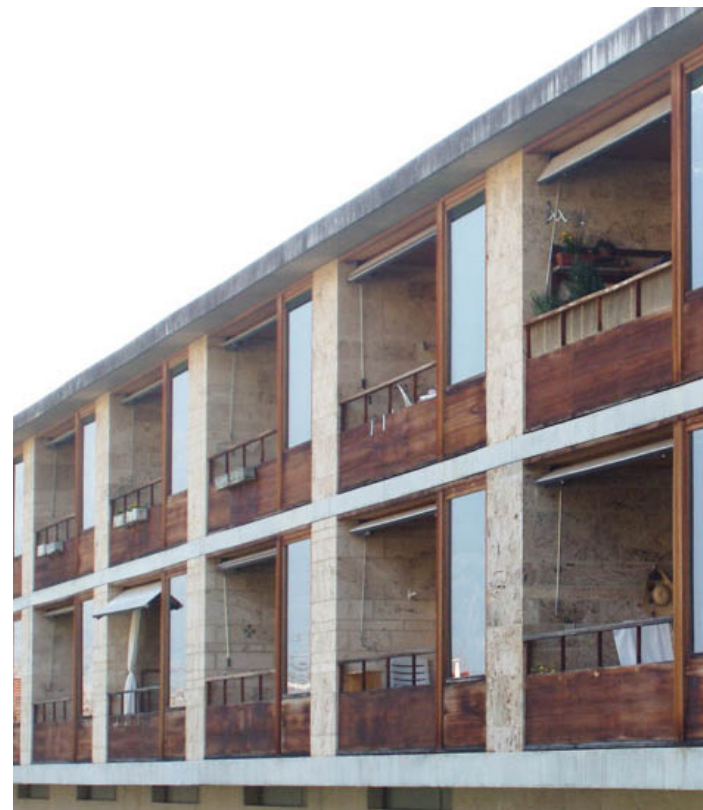
Inpandige buitenruimtes aan het park
