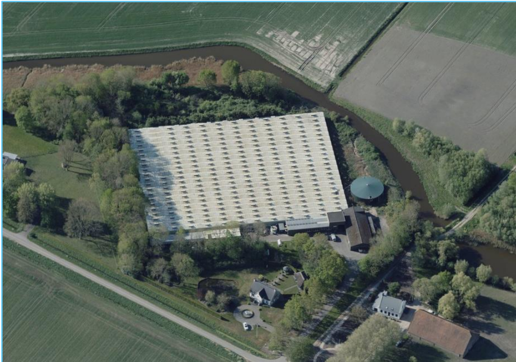
Figuur 17: Luchtfoto kijkend in zuidelijke richting. Bron: Streetsmart cyclomedia
