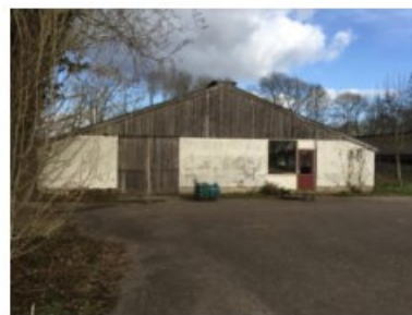
foto 3 - middelste schuur - asfaltverharding
