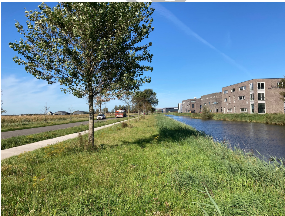
Figuur 4.4 De noordberm van de Kanaalweg wordt toegevoegd aan de groene oost-westverbinding Kanaalweg en kan bloemrijker gaan worden door 2x per jaar te gaan maaien met afvoer.
