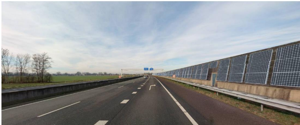
Figuur 2: Impressie zonnepanelen op geluidsscherm, A35 Wierden.
