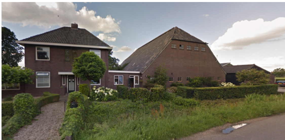
Afbeelding 4: Aanzicht huidige situatie gezien vanaf de Wolfhoeksestraat (bron: Google Streetview)
