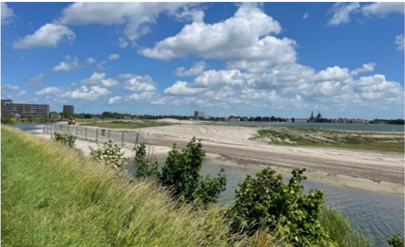
Foto 1 Aanleg nieuwe stadsstrand Hoorn, 2022
