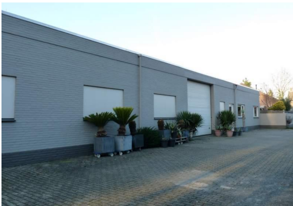
Fig. 7. Het zuidelijke bedrijfsgebouw, het deel met een plat dak..
