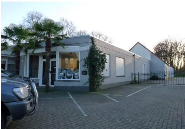
Fig. 3 Overzicht plangebied, gezien vanaf de Bergstraat. Foto genomen richting het westen
