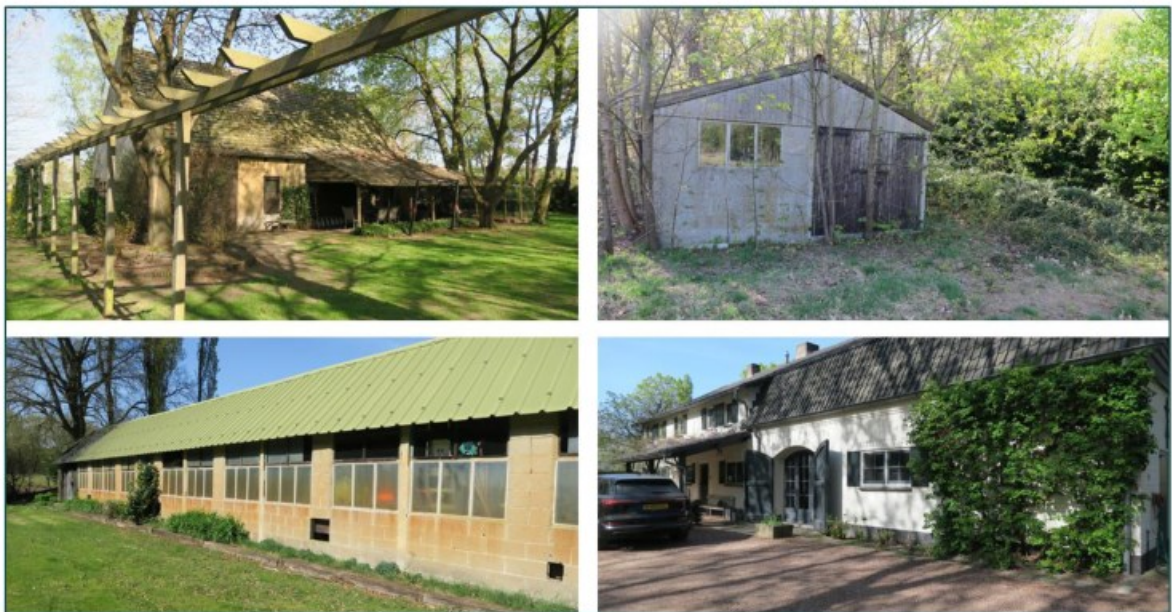
Figuur 1.4 Op de planlocatie is men voornemens om de volgende gebouwen te slopen: een woning en verschillende opstallen.
