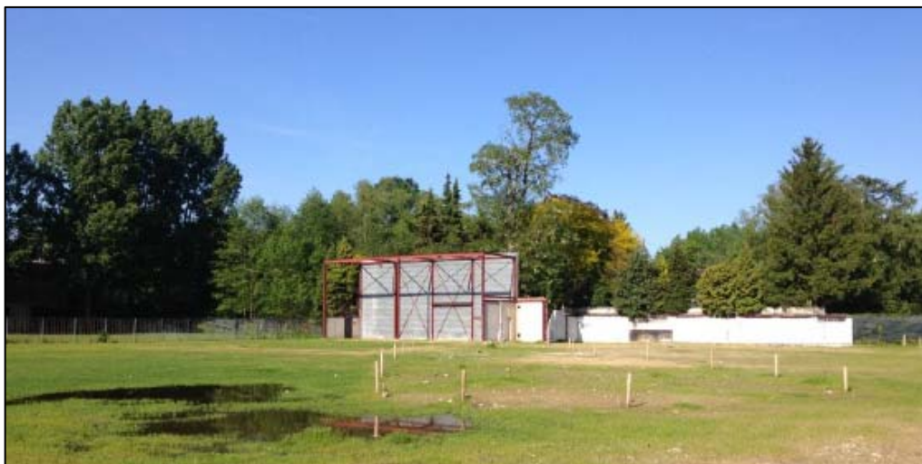
Aanzicht van het plangebied. Het grootste gedeelte van het gebied ligt braak. Op een gedeelte van het terrein zijn nog bouwwerken, geen gebouwen zijnde aanwezig.
