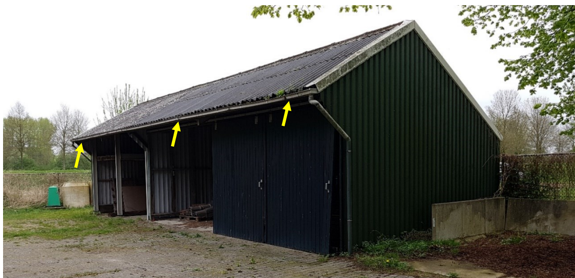
Figuur 8: De schuur op het kampeerterrein met mogelijke verblijfplaatsen achter de dakgoot (gele pijlen).
