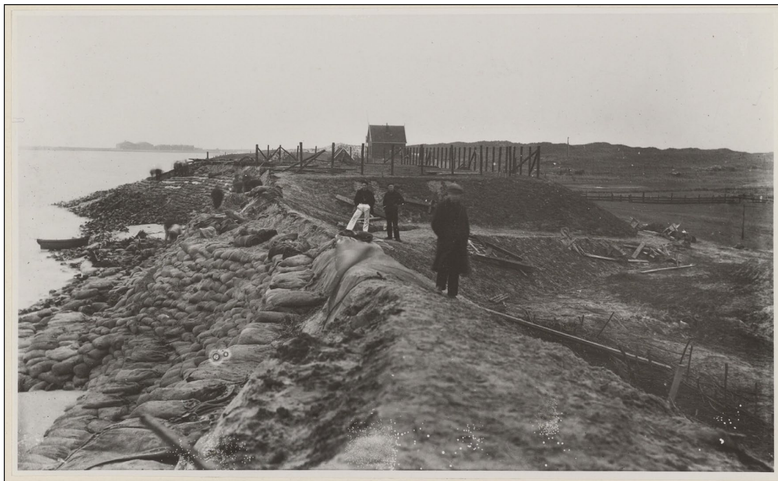
Afb. 17. Een dijkverzakking bij 't Horntje.
