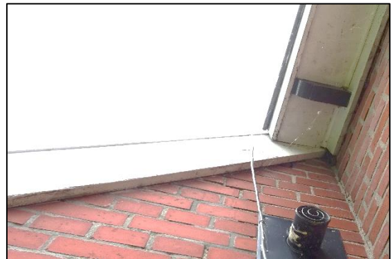
Afbeelding 3.6. Aansluiting van boeiboorden op de muur.
