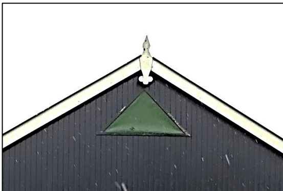
Afbeelding 3.3. Ventilatiegaten afgedicht met gaas.
