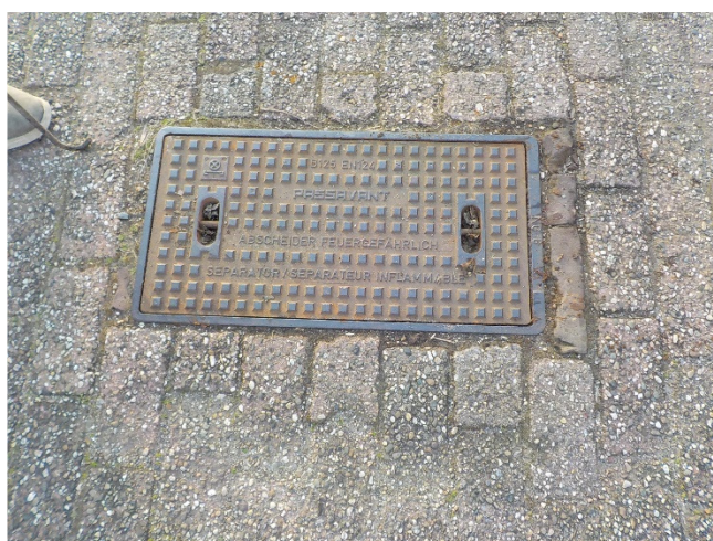
Foto 12 (detail olie/waterafseparator nabij afspuitplaats)
