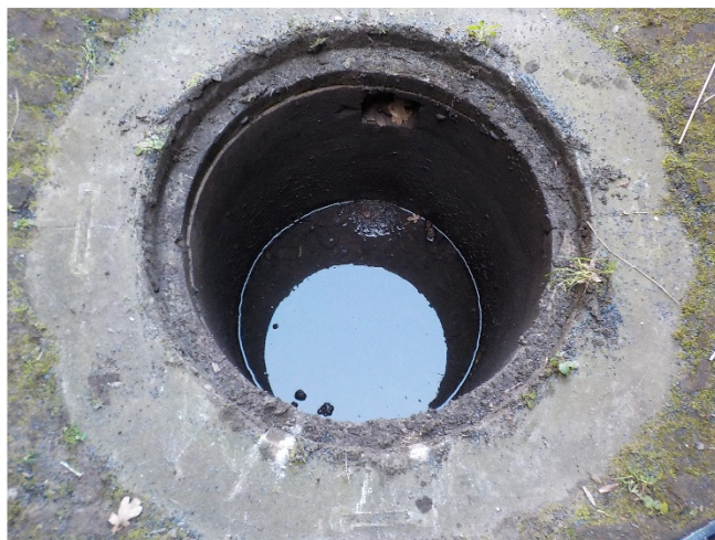
Foto 14 (inhoud bezinkput vuilwaterriolering)
