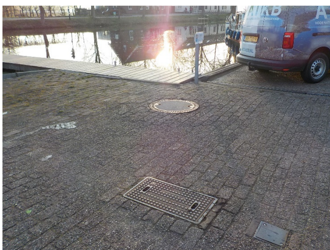
Foto 11 (putten afspuitplaats nabij entree)
