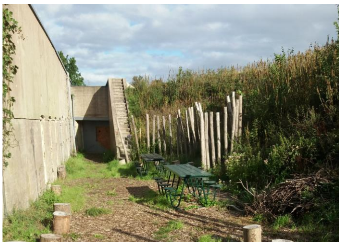
Figuur 7 Locatie gesloopte loods
