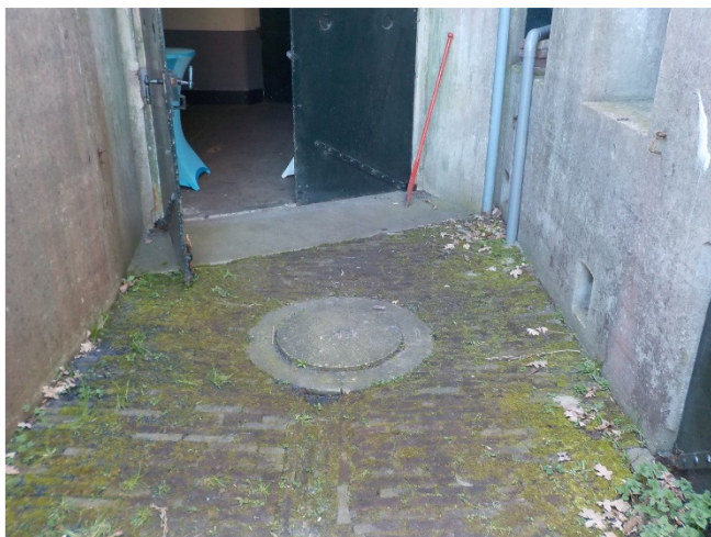
Foto 13 (bezinkput vuilwaterriolering)
