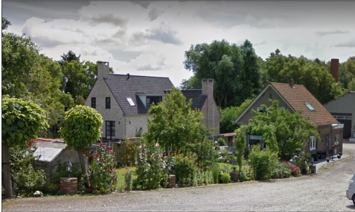
Afbeelding: twee woningen. gezien vanaf de Hoge Dijk (bron: www.google.nl/maps )
