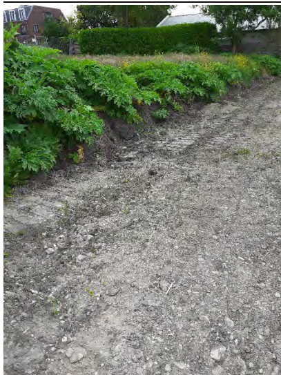
Overgang dijklichaam naar perceel
