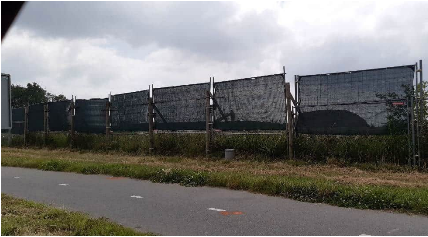
Figuur 6. Een voorbeeld van een vleermuisscherm; een kunstmatige vliegroute voor vleermuizen.
