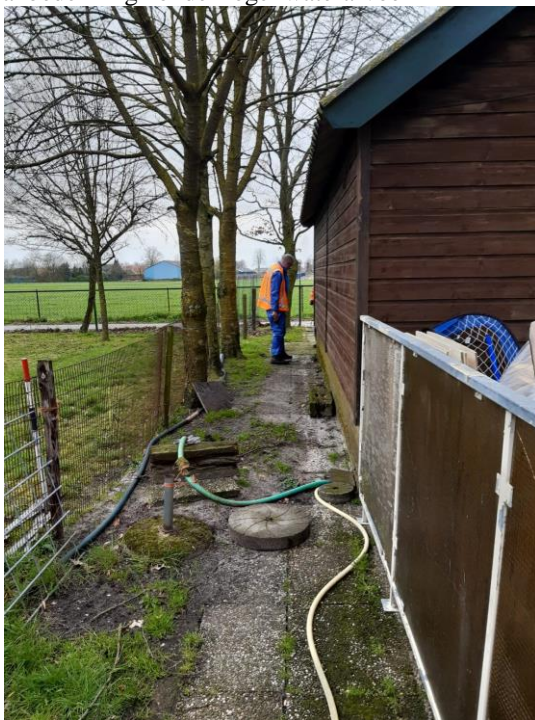
Omschrijving: Asbestverdachte dakbedekking zonder regenwaterafvoer
