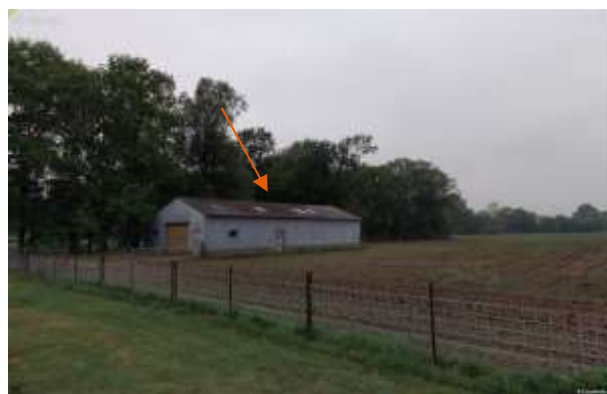
Foto 19: schuur met asbestverdacht dak op perceel van Bernhardstraat 25
