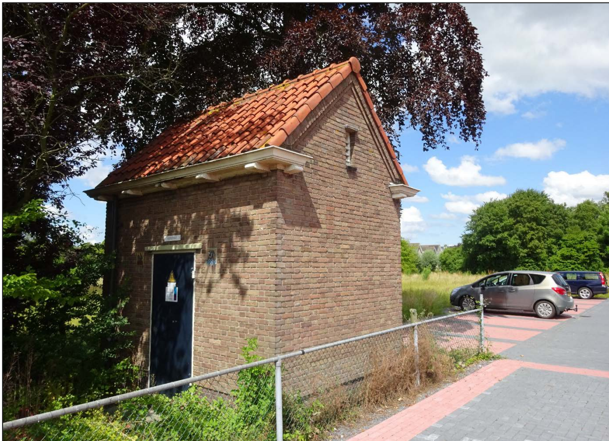
Figuur 4. Het enige gebouwtje op het perceel, een elektriciteitshuisje.
