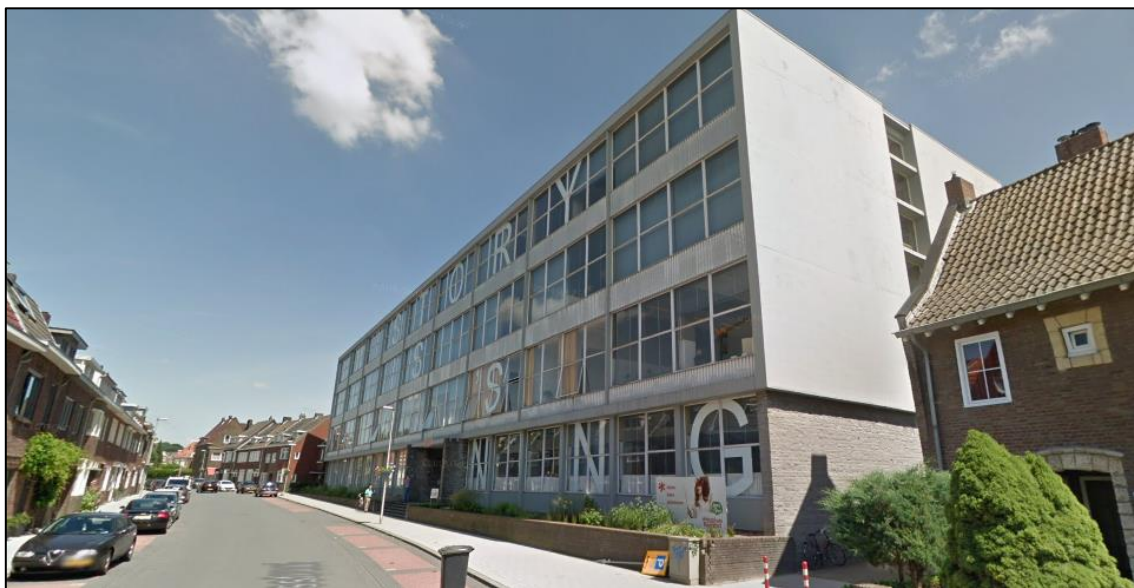
Foto voormalig HTS-gebouw Dr. Jaegersstraat 40 (bron: Google maps, juni 2018)
