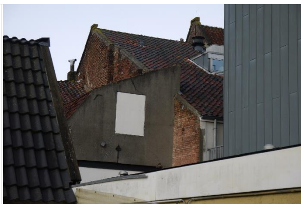
Detail kopgevel Voorstraat 36
