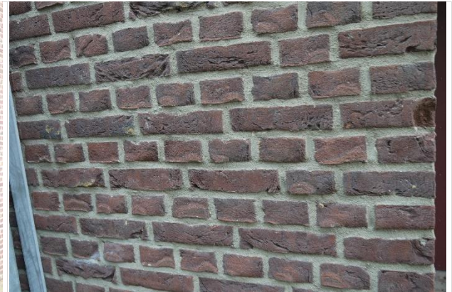
Gevel metselwerk Kerkstraat 9
