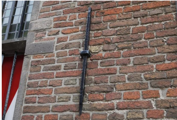
Detail gevelanker
