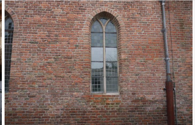
Overzicht gevel metselwerk
