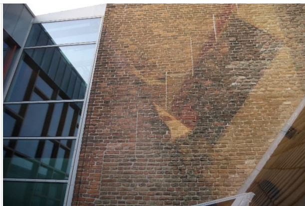
Bouwsporen in het metselwerk
