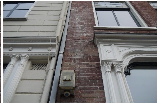
Overzicht metselwerk Voorstraat 36
