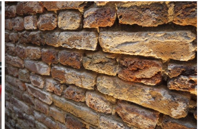
Binnen metselwerk oudbouw
