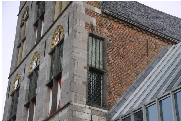
Voorgevel ter hoogte van eerste verdieping nr.30
