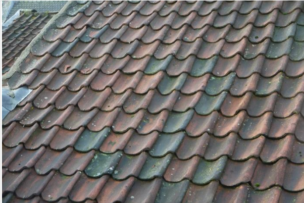
Pannenbedekking zijde Voorstraat
