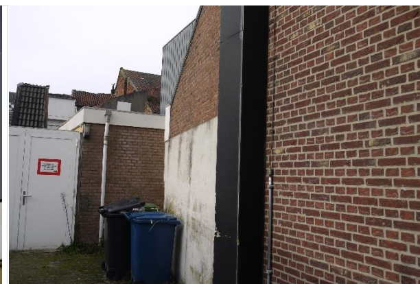
Gevel Zuid ter hoogte van Kerkstraat
