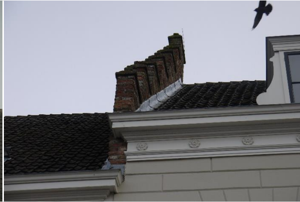
Opgaand metselwerk tussen de dakvlakken
