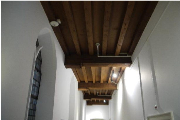
Houten plafonds en balklagen oudbouw
