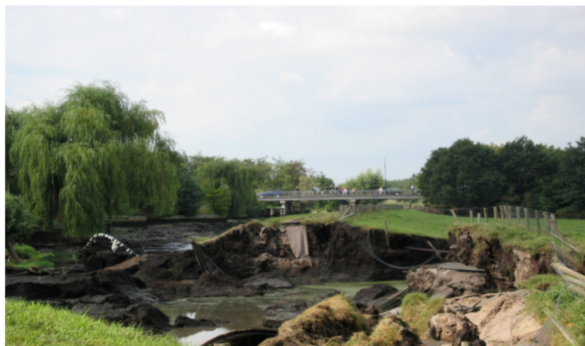
Figuur 1-4. Zicht op de bres en kijkers op de brug
