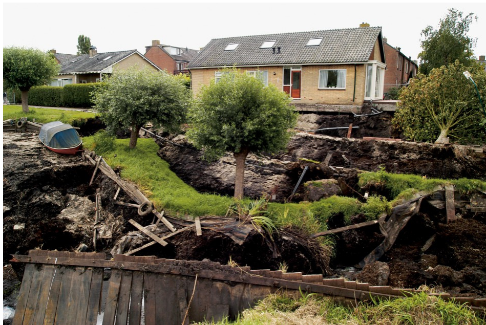
Figuur 1-5. Ingezakte boezemkade en tuin als gevolg van het droogvallen van de Ringvaart
