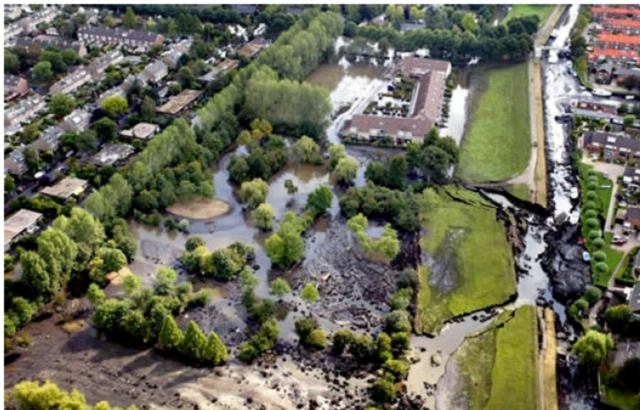
Figuur 5-1. Afgeschoven veenkade te Wilnis in augustus 2003
