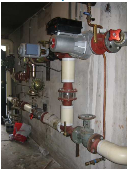
Foto 2-9: Aflevering en distributie verwarming.
