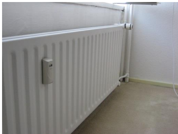
Foto 2-5: Stijg-/zakleiding per ruimte.
