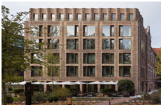
Bakstenen gevel met een bijzondere kroon krijgen een rijke uitstraling door verbijzondering in metselverbanden - Pillow, Amsterdam (ontwerp: Winhov).
