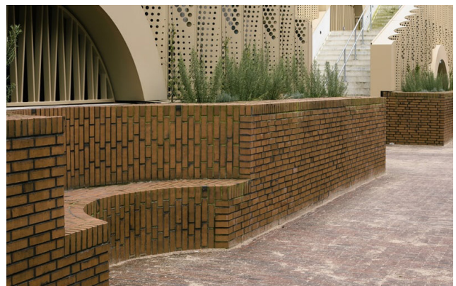
Het ondersteel deel van de plint wordt uitgevoerd in baksteen en voorzien van zitelementen en groenvakken - Parkeerhuis, Nijmegen (ontwerp: Korthtielens architecten).
