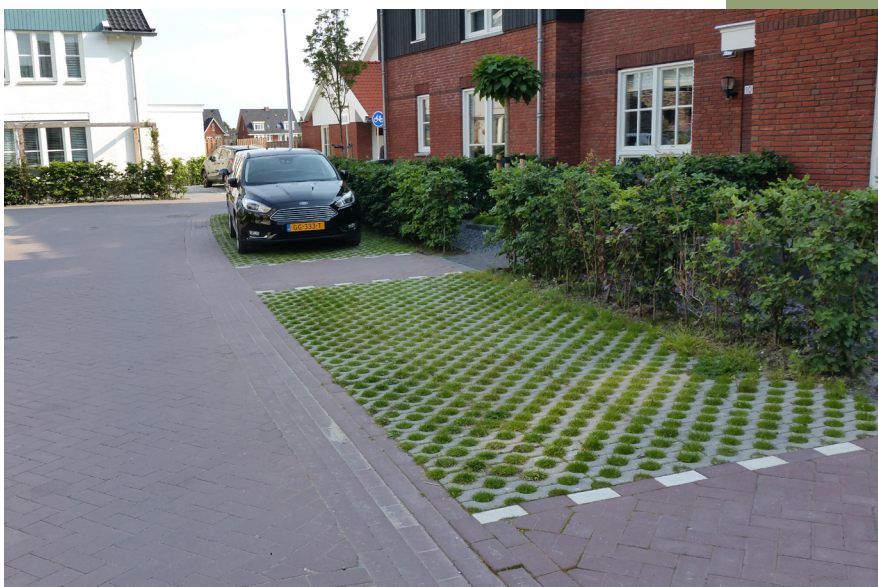
Waterdoorlatende parkeervak (ontleend aan: Nanda Sluijsman).
