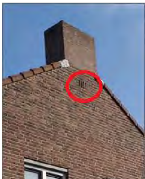
Figuur 3.1 Open stootvoegen.
