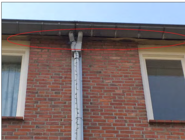
Figuur 3.1 Open dakrand bij Tripstraat en Kamperstraat.
