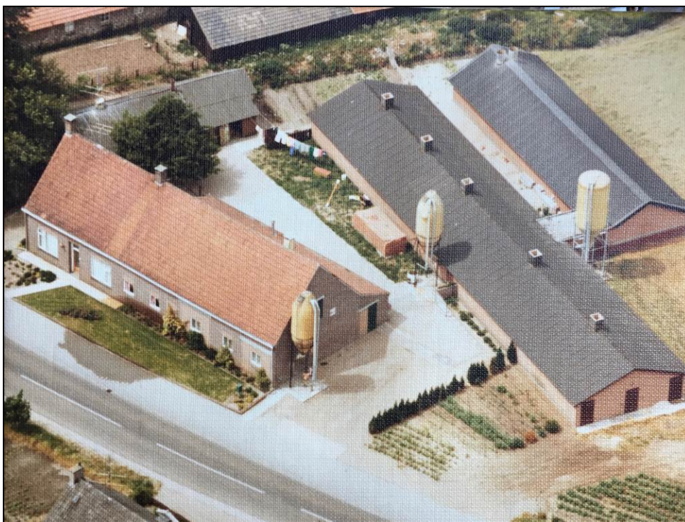
Figuur 14: Luchtfoto locatie varkenshouderij in bedrijf
