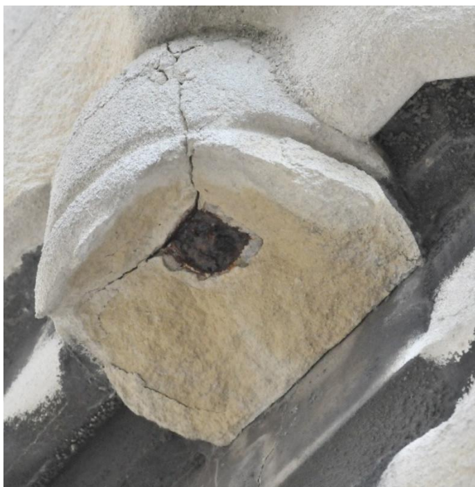
Afb. 9 - Reeds losgekomen stuk natuursteen, met duidelijk roestend ijzer van een dook
