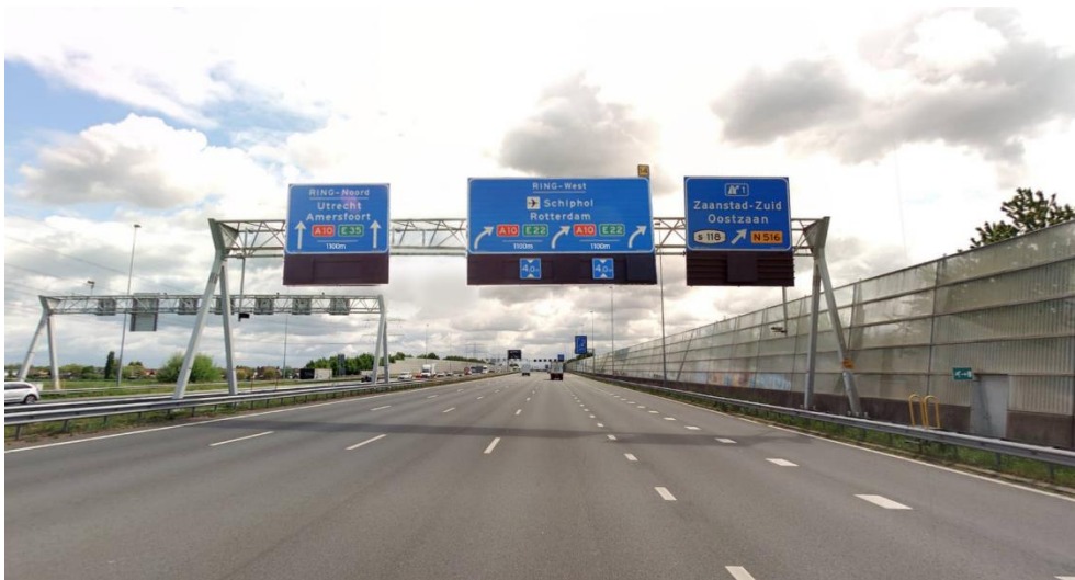
Figuur 5.17: mitigerende maatregel eerder informeren splitsing
