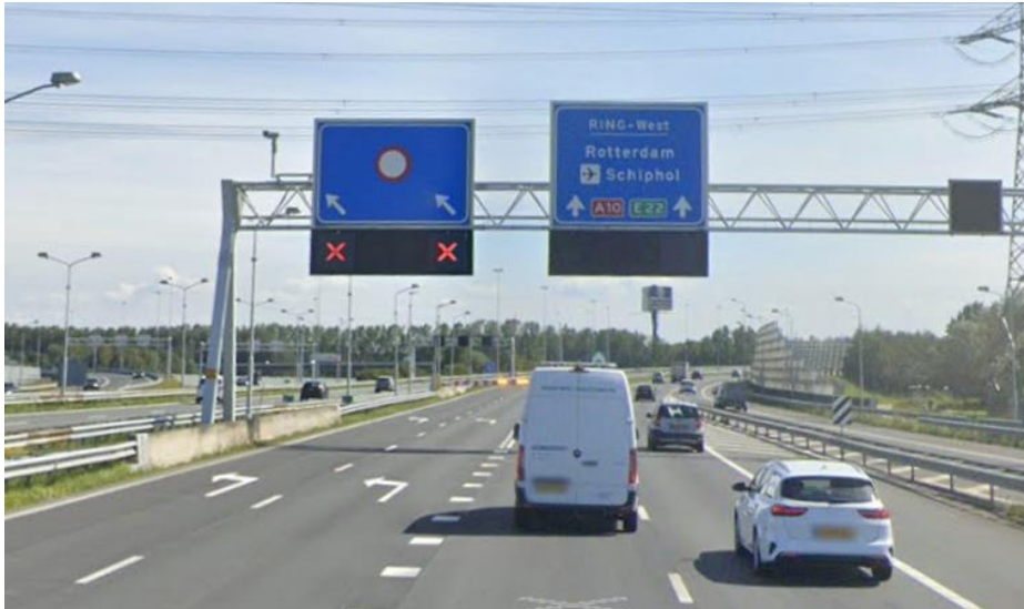
Figuur 5.7: Bestaande situatie nadering keuzepunt
