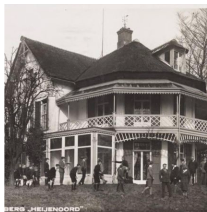
1. Jeugdherberg Heijenoord | Dit prachtige gebouw gelegen op het landgoed is helaas verloren gegaan
