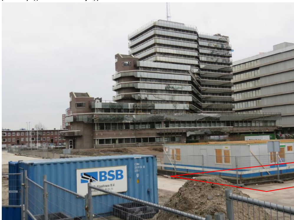
Gezicht op de Luitenant-Generaal Knoopkazerne (Mineurslaan 500) te Utrecht die wordt omgebouwd tot Rijksgebouw de Knoop, vanuit oostelijke richting. Aan de voorzijde deels zichtbaar een verlaagd gelegen terrein, dat zal worden heringericht als parkeerterrein. Foto genomen op 06-02-2016. Het zichtbare zuidoostelijke deel van het plangebied (rode belijning) ligt ter hoogte van de tijdelijke bouwkeet en een gedeelte van een met stelconplaten verhard terrein (Bron: https://hetutrechtsarchief.nl/ )
