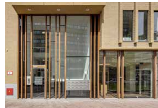
Tactiele detaillering pui: woongebouw, Eindhoven - Grosfeld Bekkers van der Velde.
