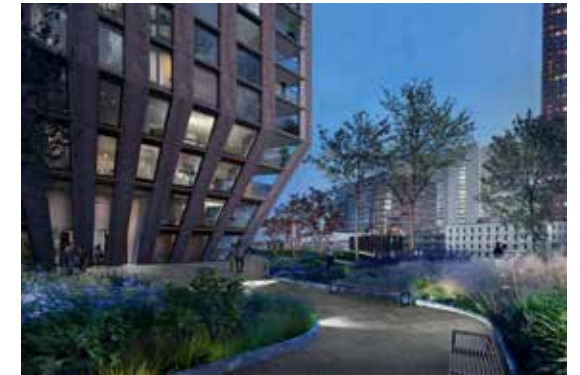
Groene terrassen: woontoren Casanova, Rotterdam - Barcode Architects.
