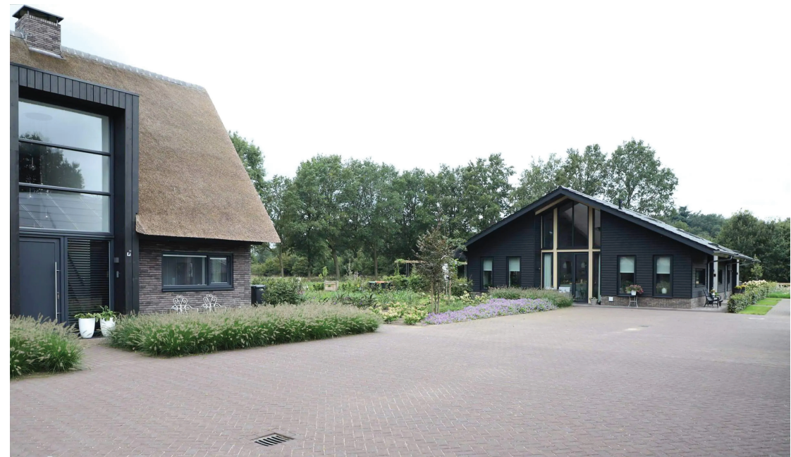
Informeel erf met grijze klinkerverharding
