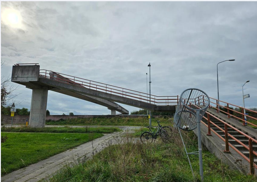
Fietsbrug over de A12
