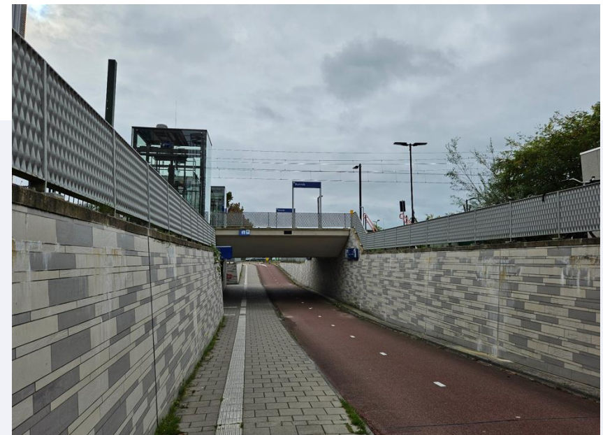
Fietstunnel onder station Bunnik
