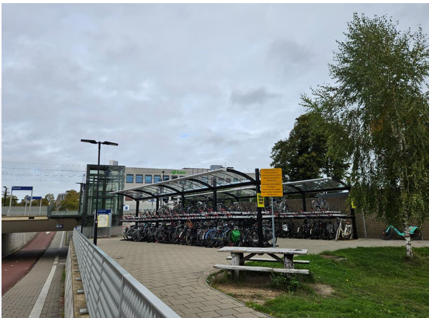
Fietsenstalling aan zuidzijde van station Bunnik
