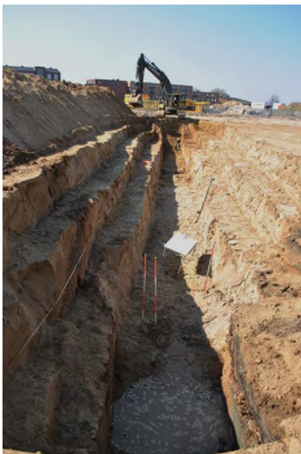
9. Aanleg van werkput 1. Om in het losse zand diep te kunnen graven is het nodig om trapsgewijs te graven.
