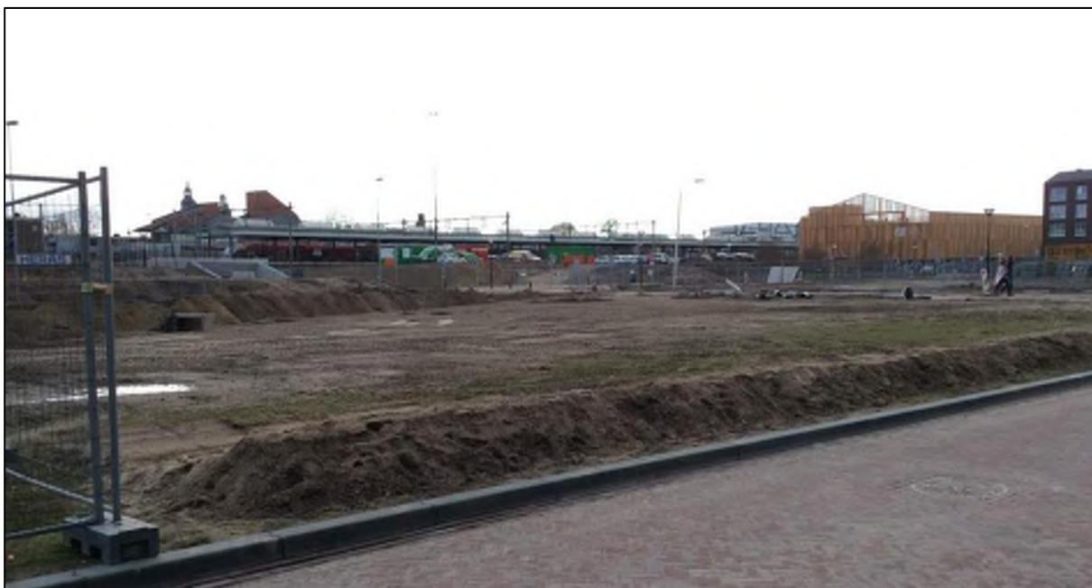
Zicht over het plangebied vanaf de Noorderhavenstraat. Op de achtergrond het spoor en de spooronderdoorgang.
