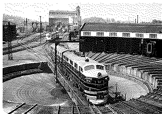
26. Boven: de ASK geprojecteerd op de kaart van Etteger uit 1878 met in de gestippelde cirkel de ronde gemetselde structuur die is aangetroffen. 27. Rechtsboven: een foto van de ronde gemetselde structuur. 28. Rechts: een foto van een draaischijf waarop een locomotief of treinstel kan worden gedraaid en in de richting van de juiste loods of werkplaats kan worden gereden.
