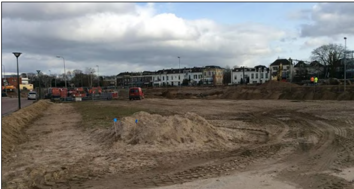
Zicht op het plangebied richting het zuidoosten. Rechts het spoor dat het zuidoosten van het plangebied begrenst.
