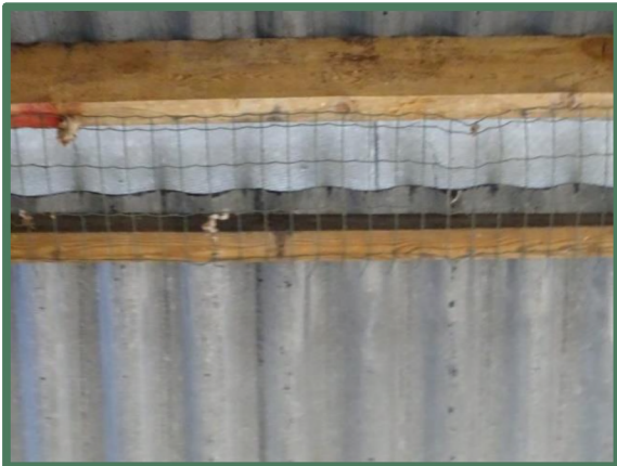
Gaas tegen dak binnenzijde oude rundveestal
