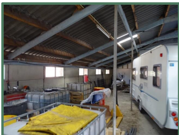
Binnenzijde oude rundveestal
