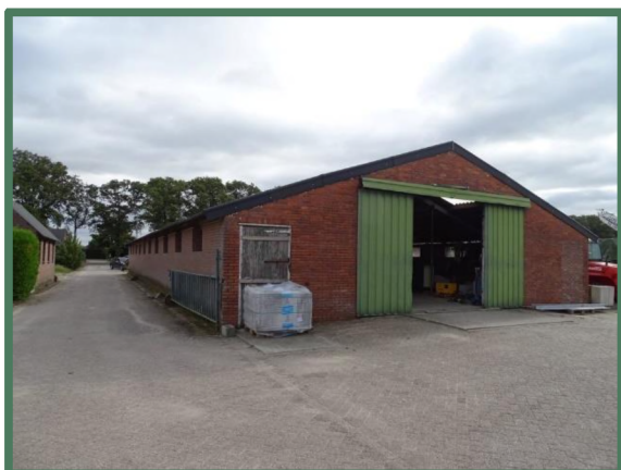
Zuidwest- en noordwestzijde oude rundveestal
