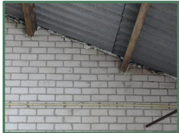
Purschuim aan binnenzijde veldschuur
