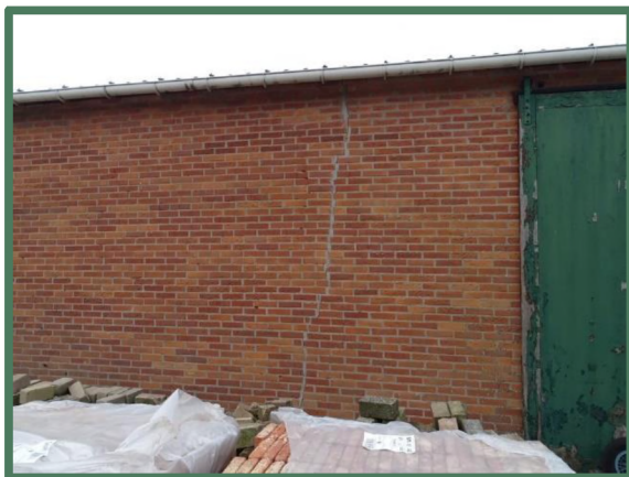
Gedichte voegschade veldschuur
