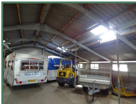
Binnenzijde oude rundveestal
