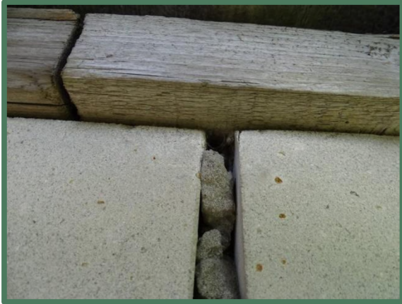
Muurplaat lager deel veldschuur
