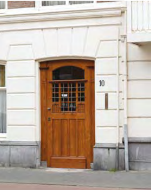
Afb. 14: De voordeur van Elandstraat 10 werd eind jaren twintig vervangen door Jan Hendrik van Dalen (foto Arjan Bronkhorst)
