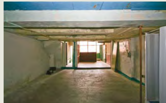
Begane grond voor restauratie
