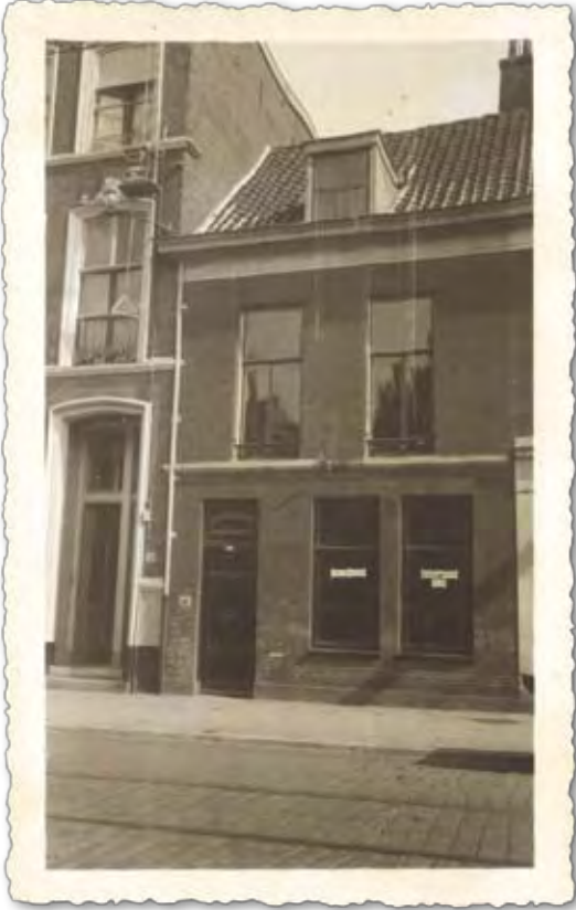
Afb. 48: De voorgevel van Mauritskade 71 voor de verbouwing van 1939
