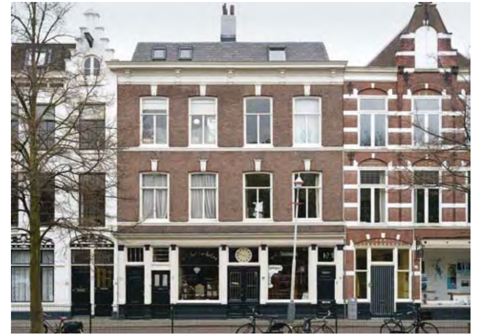
Afb. 31: Toussaintkade 15-19. De winkelpui is grotendeels in oorspronkelijke staat bewaard gebleven. Het dak is gewijzigd (foto Arjan Bronkhorst)
