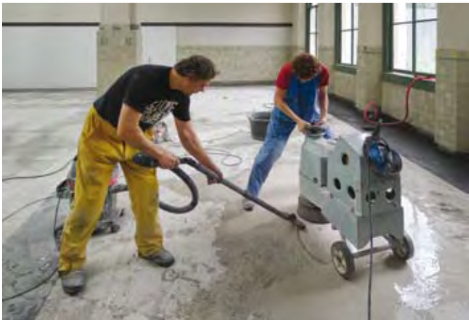
Dordrecht, Wijnstraat 153, Huis Rodenburch, het aanbrengen van de granitovloer door vader en zoon Varró (foto Martine de Heij)
