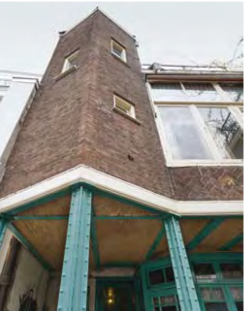
Afb. 28: Elandstraat 12, uitbouw aan achterzijde (foto Arjan Bronkhorst)
