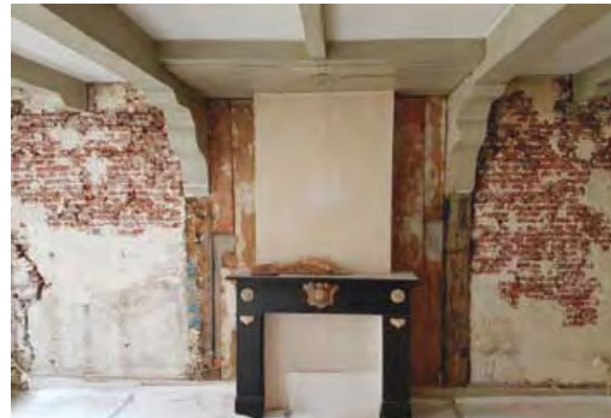
Amsterdam, Rapenburg 13, voorkamer verdieping voor restauratie
