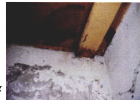
Aangetaste balkkoppen als gevolg van lekkages
