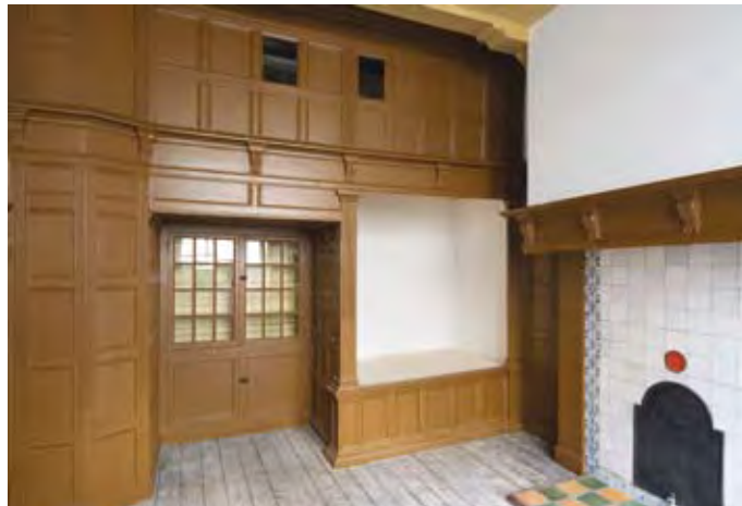
Amsterdam, Rapenburg 13, bedstedewand in de keuken na restauratie (foto Arjan Bronkhorst)
