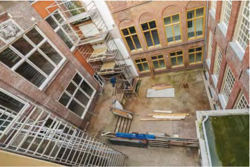
Leeuwarden, Koningsstraat 13-25, Huis Van Eysinga, de binnenplaats tijdens de verbouwing (foto Zien!)
