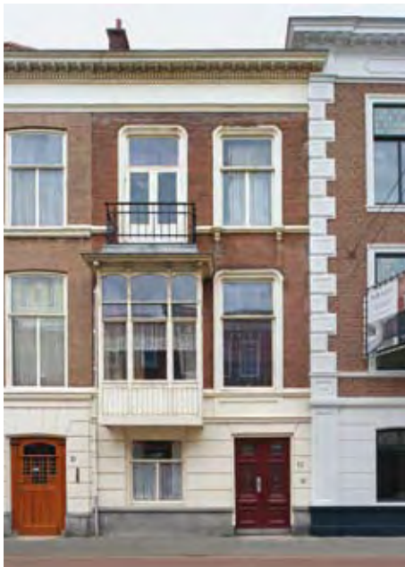
Afb. 20: Elandstraat 12. De erkeruitbouw dateert uit 1902, de voordeur is oorspronkelijk (foto Arjan Bronkhorst)
