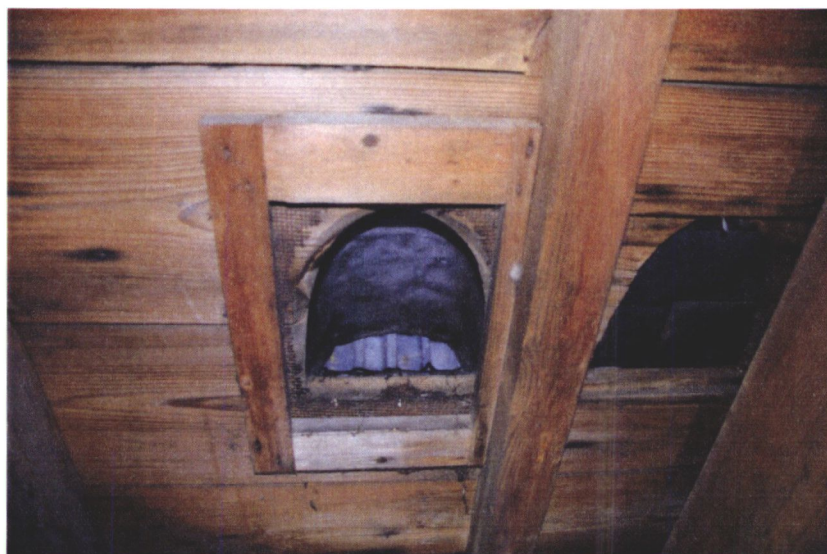
Ventilatieopeningen torensproeten, insectenroosters zijn vergaan
