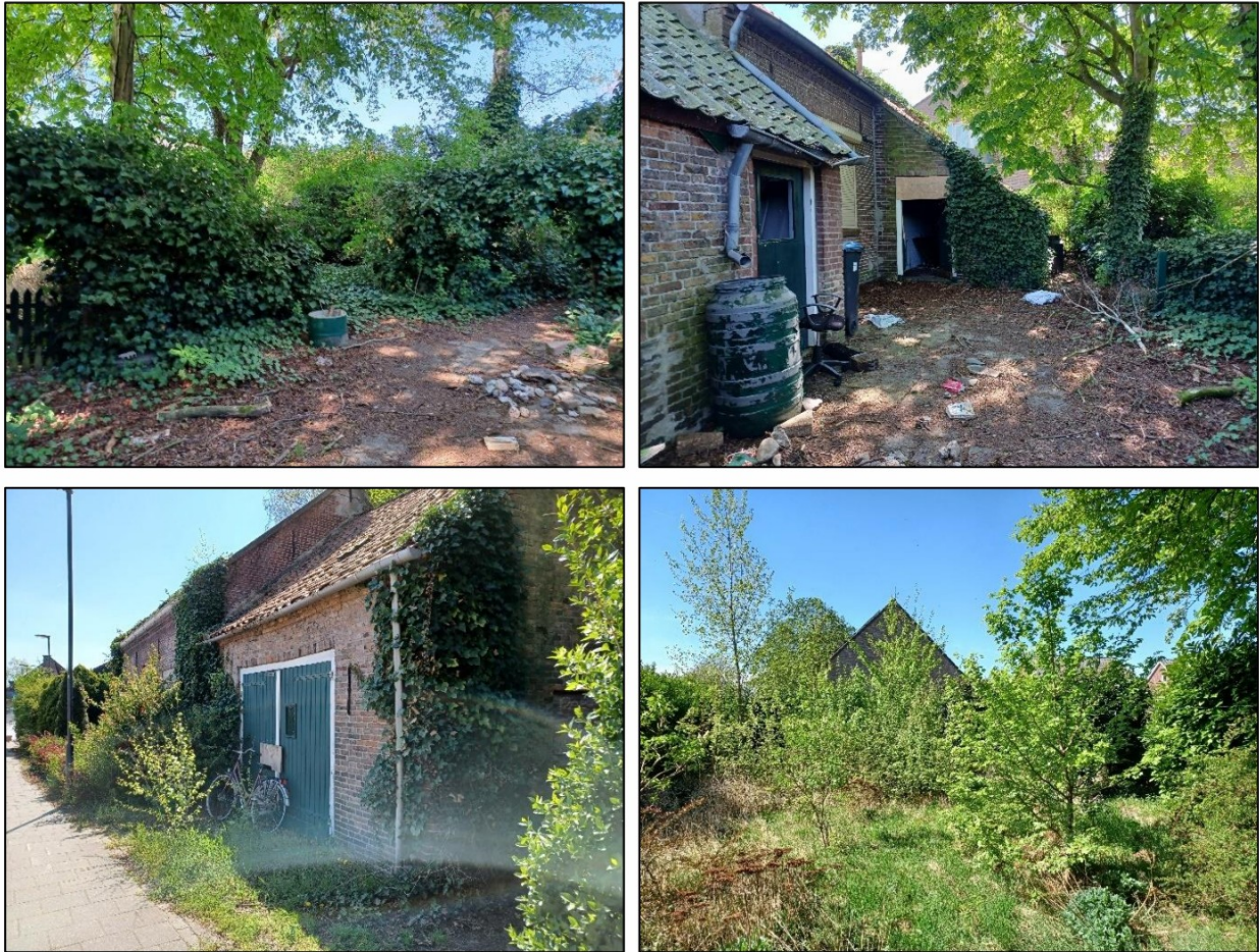
Figuur 8. Overzichtsfoto's van het zuidelijke deel van het plangebied.
