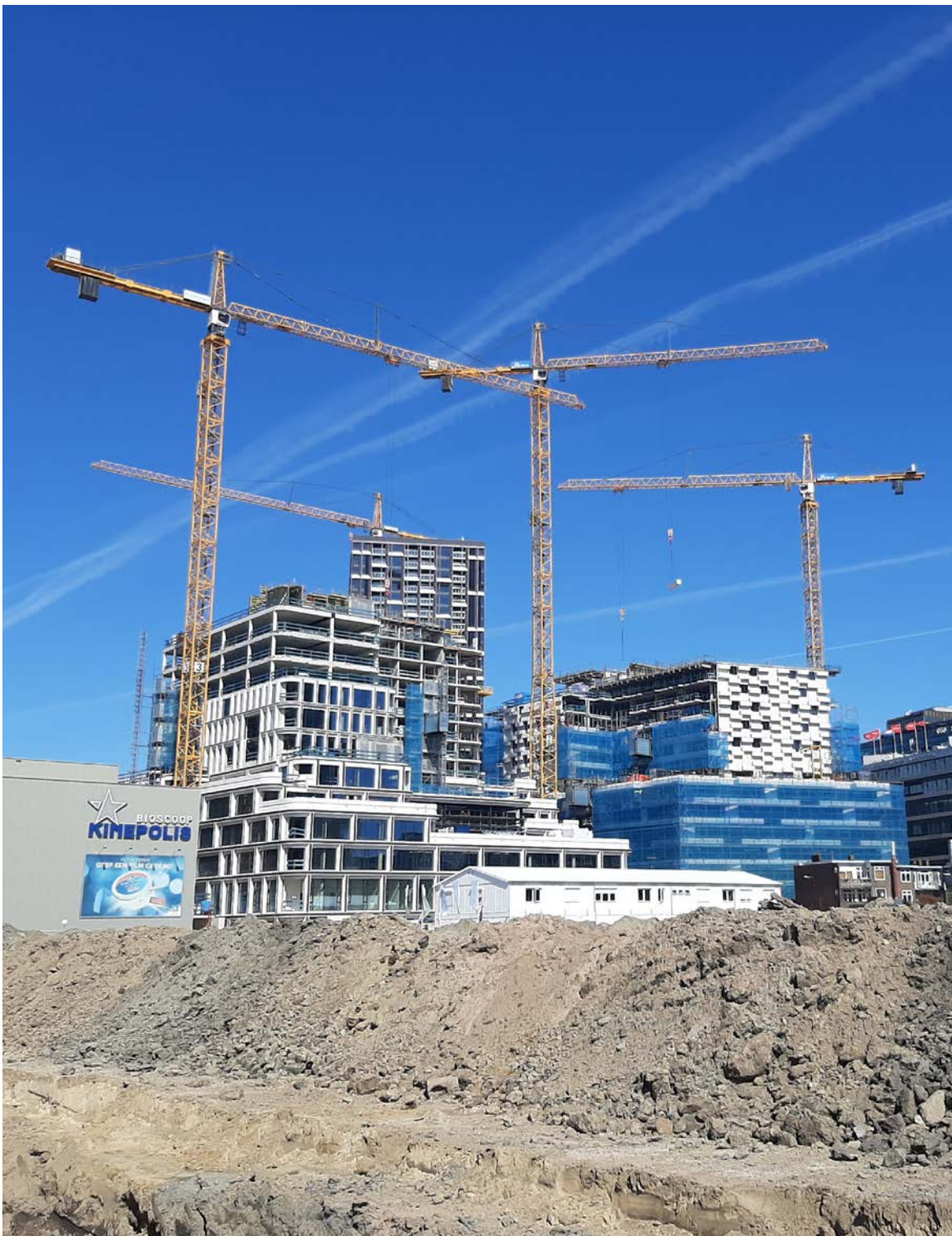
Wonderwoods in aanbouw (2024)
