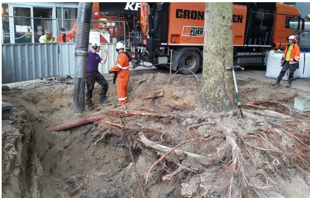
Vredenburg: verknoping van boom, kabels en leidingen (2022)
