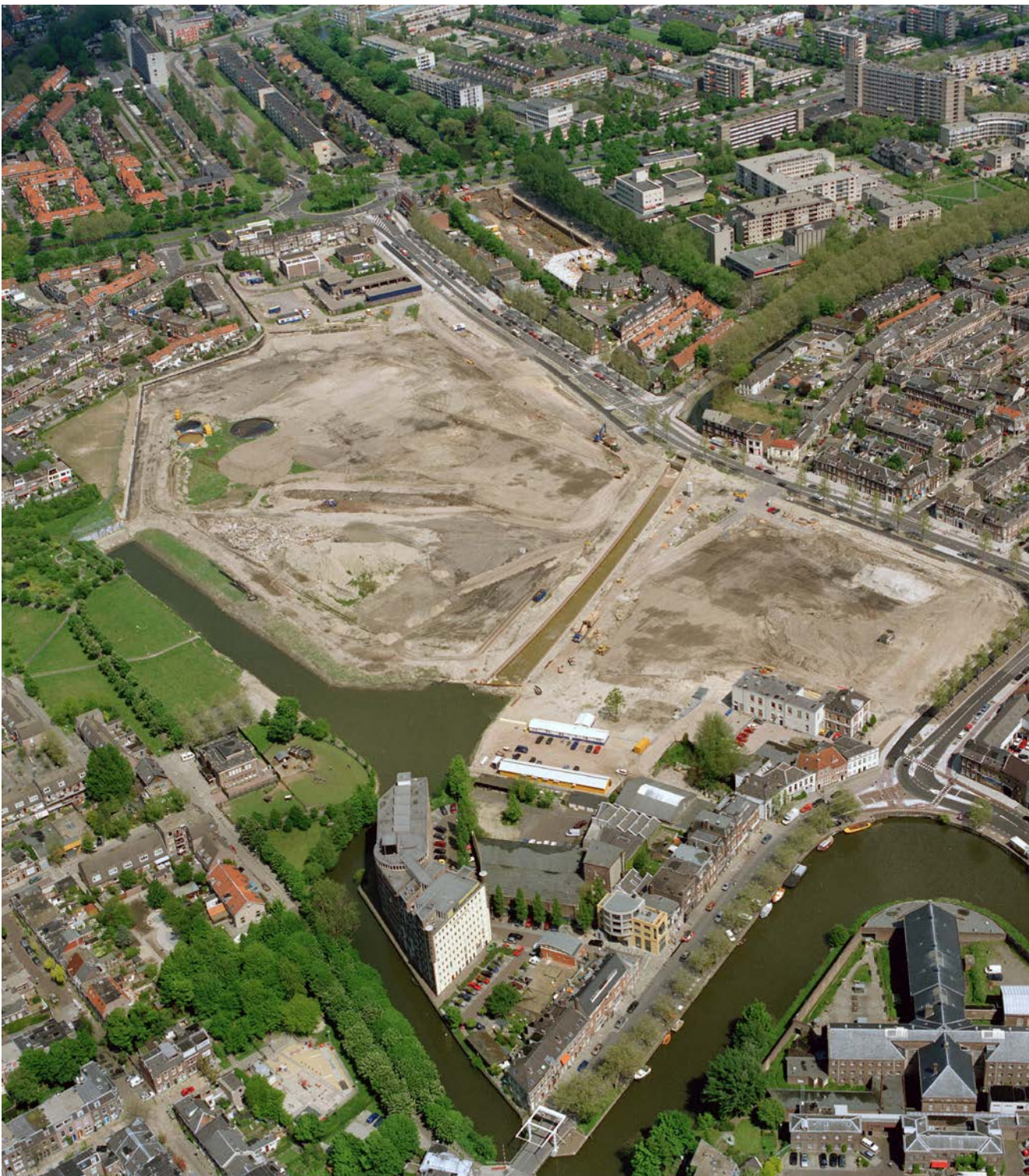
Luchtfoto van de saneringswerkzaamheden in het Griftpark en aan de Blauwkapelseweg-Kleine Singel (boven) te Utrecht (1997)
