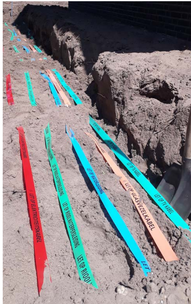
Markeringslinten van kabels en leidingen
