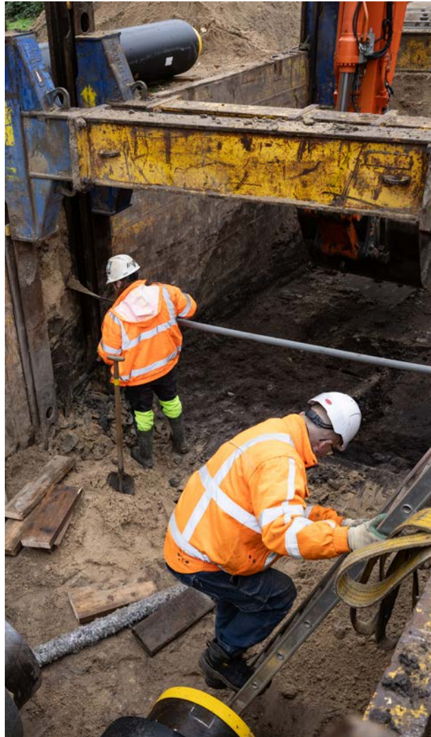
Aanleg warmtenet, Marnixlaan (2024)
