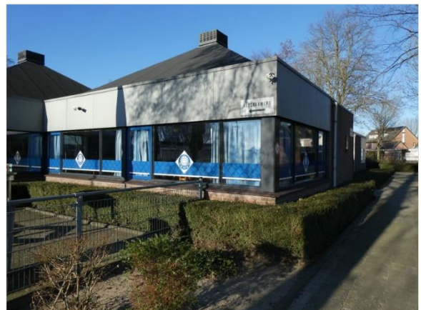
Figuur 4.1 Alle gebouwen op de onderzoekslocatie hebben geen dakpannen.
